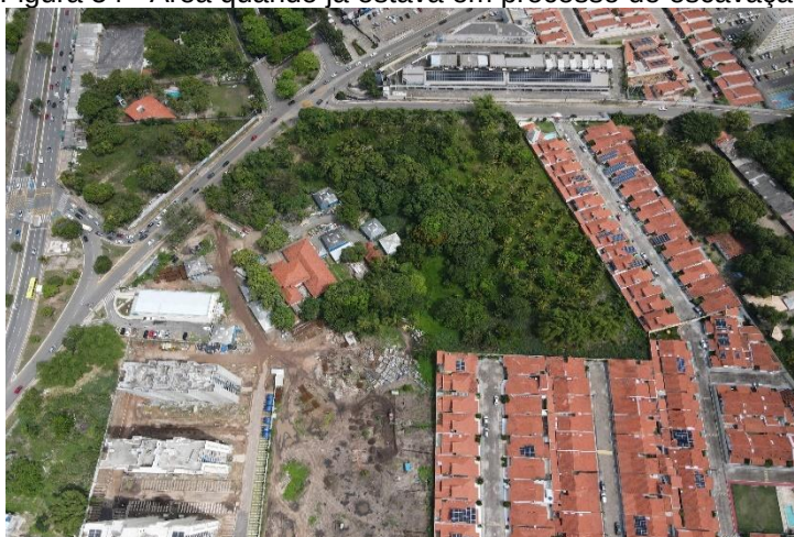
Figura 54 - Área quando já estava em processo de escavação
