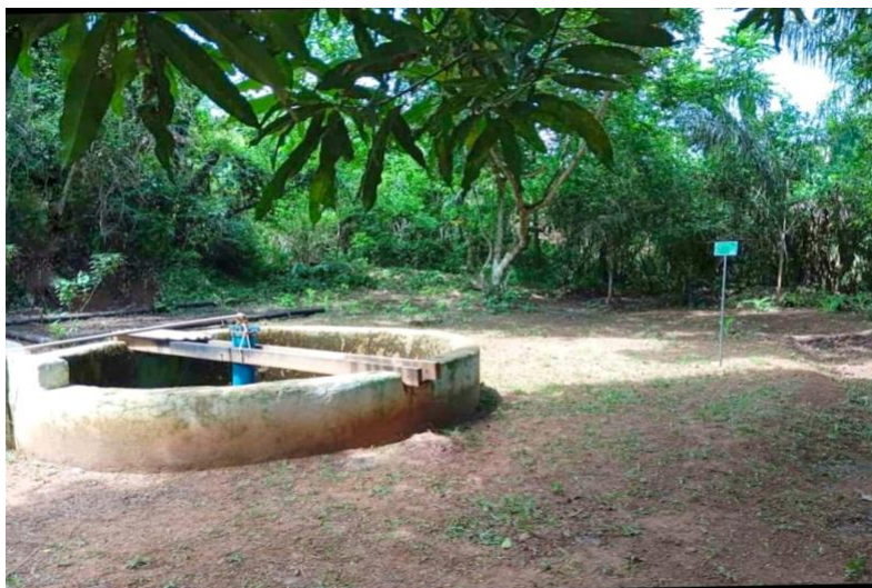
Figura 6 – Poço de pedra
