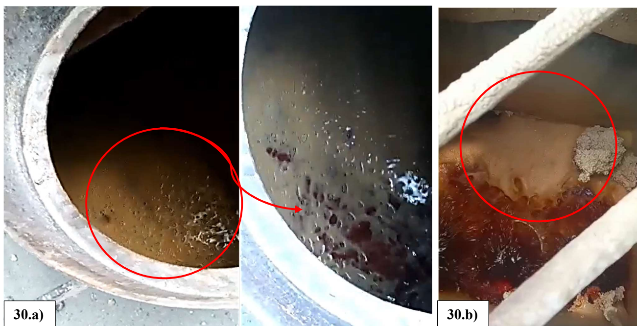
Figura 30 – a) Espumas na zona superior dos espessadores; b) Caixa de transbordo dos espessadores
