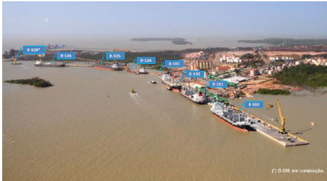
Figura 04: Porto do Itaqui: 07 berços em operação e 01 em construção
