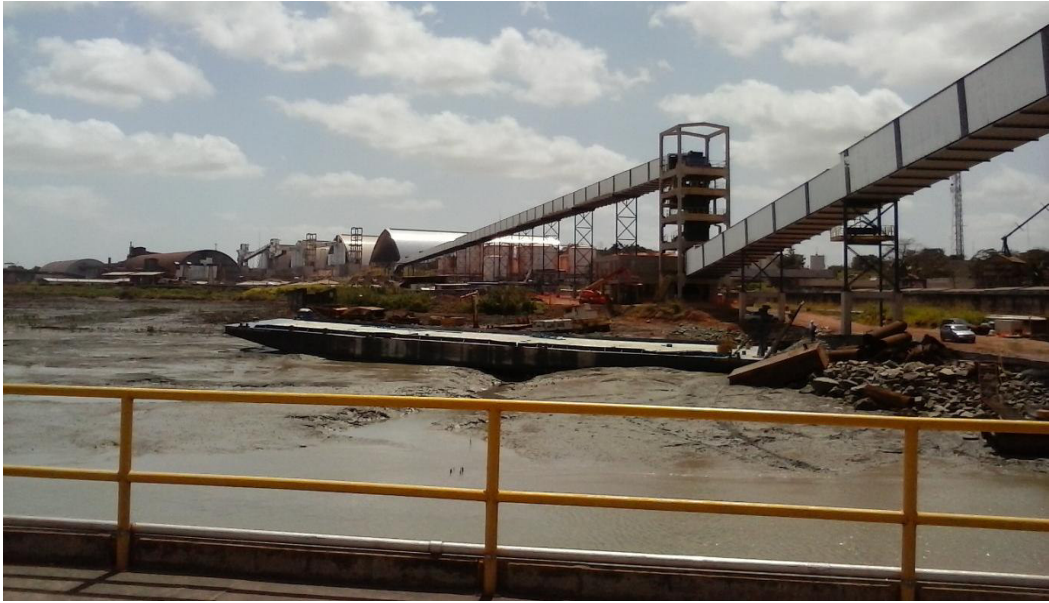
Figura 06: Sistema da galeria de correia transportadora – TEGRAM
