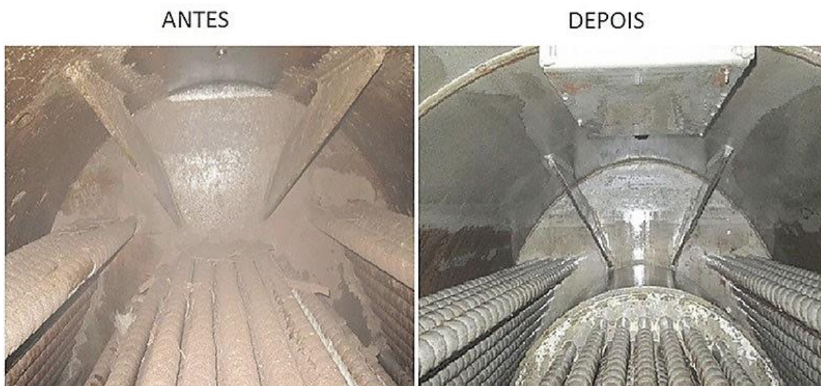
Figura 7 – Tratamento de incrustação em caldeira: Antes e depois.
