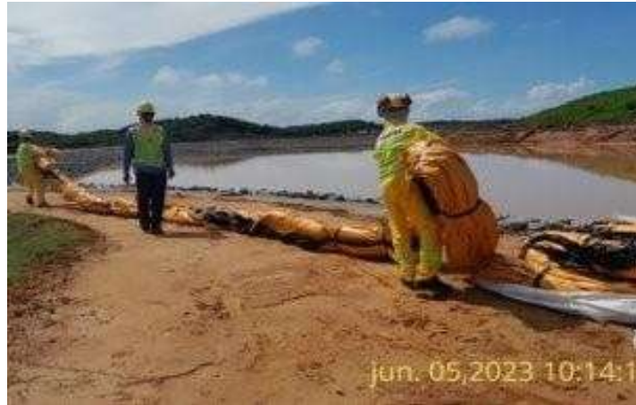
Figura 6 - Transporte e posicionamento da barreira flutuante utilizando cabo guia.
