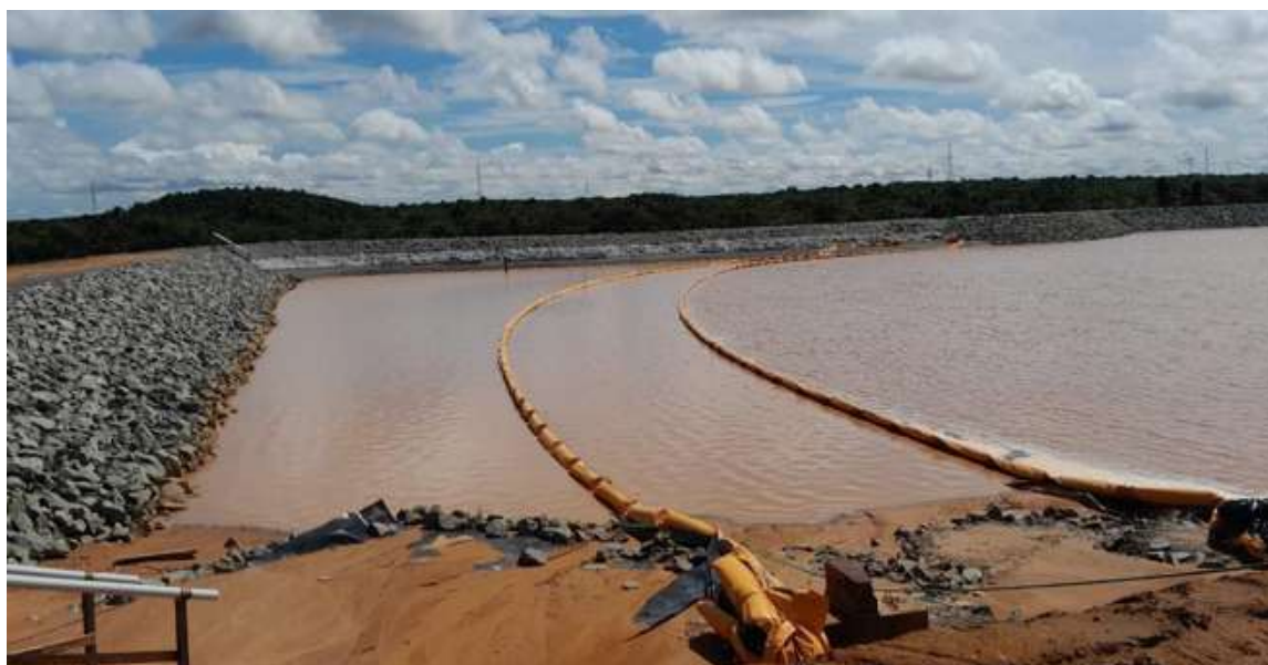
Figura 11 - Retenção de camada oleosa na primeira cortina de contenção.
