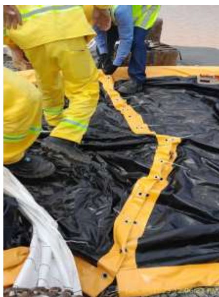
Figura 3 - Montagem da cortina de filtração.
