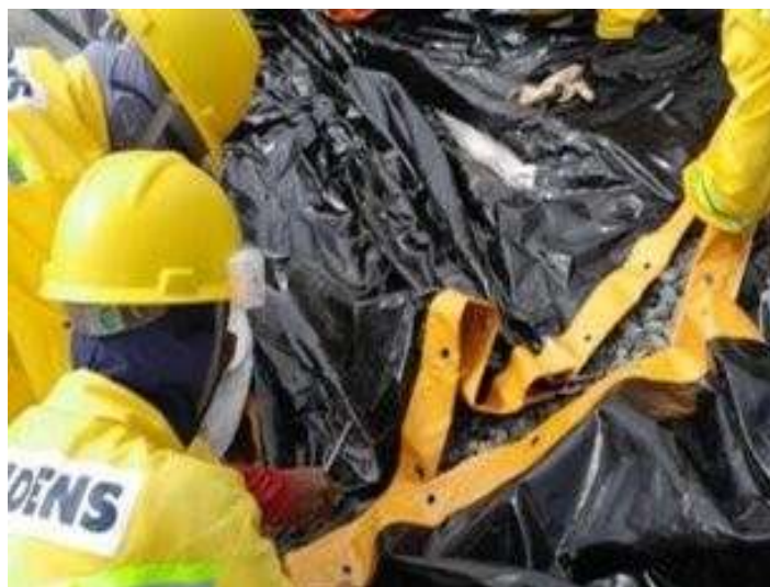
Figura 8 - Ajuste final e união das seções da barreira flutuante.
