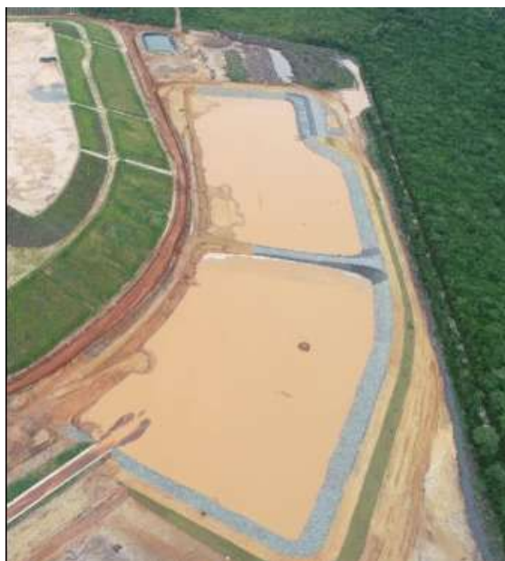
Figura 5 - Vista geral da bacia de sedimentação localizada a jusante da área de disposição de resíduos de bauxita, no município de São Luís, Maranhão.
