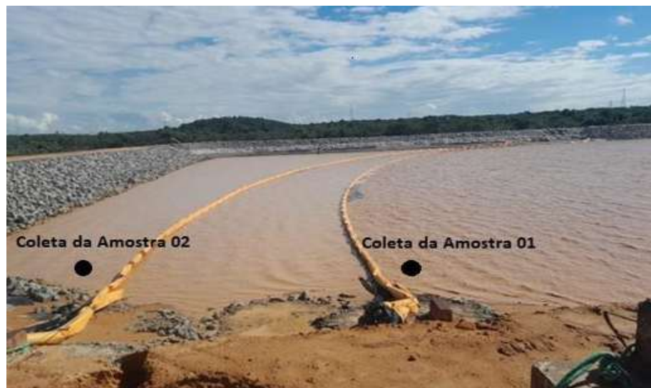
Figura 12 - Pontos de coleta utilizados no monitoramento da eficiência das barreiras, localizados estrategicamente antes e após o sistema de contenção.
