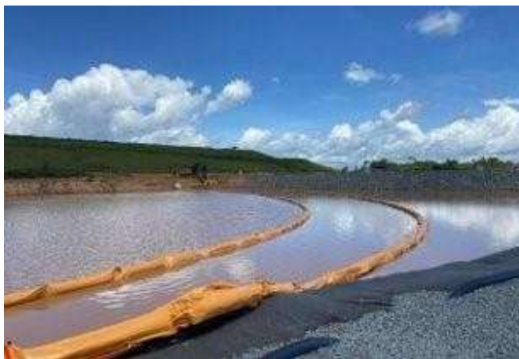
Figura 9 - Cortinas de contenção instaladas e em operação no local de estudo, com os pontos de monitoramento visíveis ao fundo, evidenciando a instalação em pleno funcionamento.
