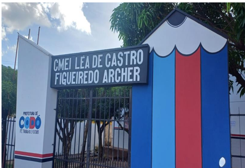
FIGURA 01: Fachada da creche.
