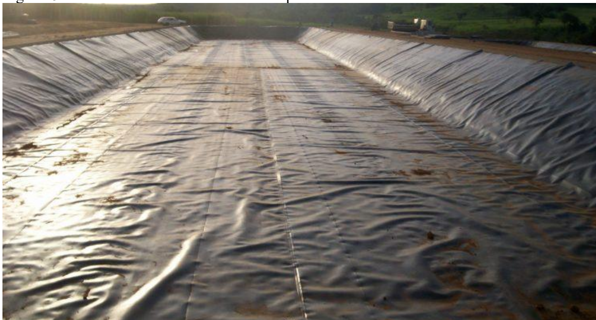
Figura 5 - Geomembrana de PEAD alocada para isolamento de fluidos.
