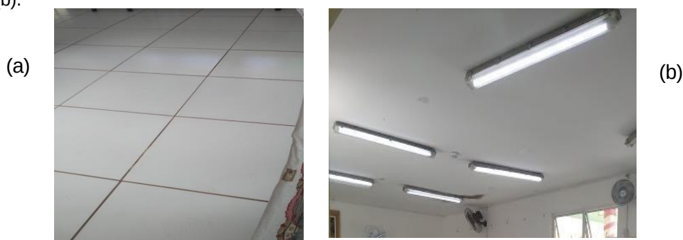
Figura 5– Estruturas físicas da Instituição de Longa Permanência pesquisada, pisos (a) e teto(b).
