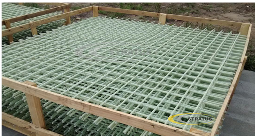
Figura 3: Telas de GFRP em laje bidirecional.
