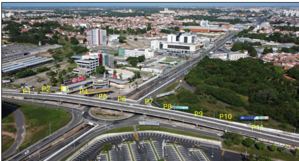
Figura 4 – Imagem aérea do Viaduto sentido Cohama - Bequimão
