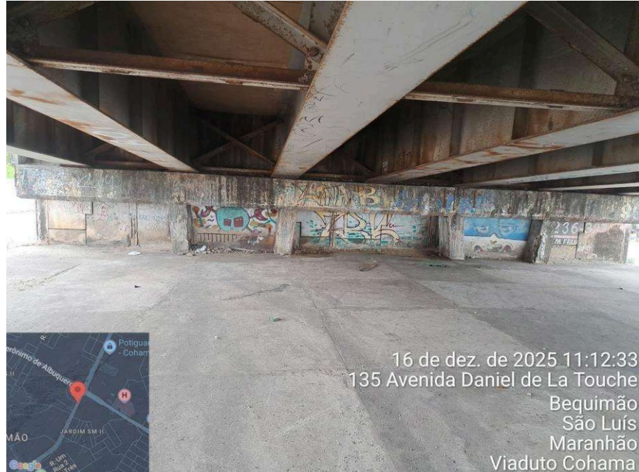
Figura 17 - Visão geral do Pórtico 11
