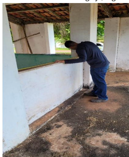
Figura 4 - Visita Técnica na Igreja, Agrovila:
