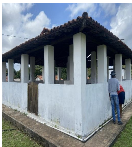
Figura 8 - Visita Técnica Lavanderia, Agrovila Cajueiro
