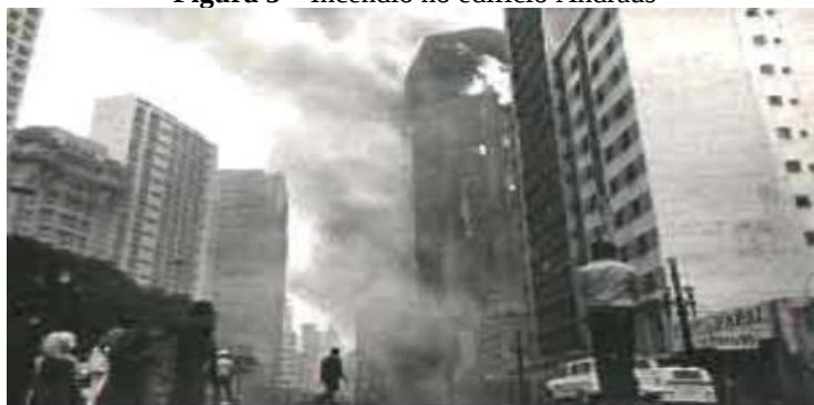
Figura 5 – Incêndio no edifício Andraus
