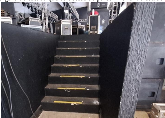
Figura 15 - Largura de escada que dá acesso ao palco inferior ao estabelecido por norma
