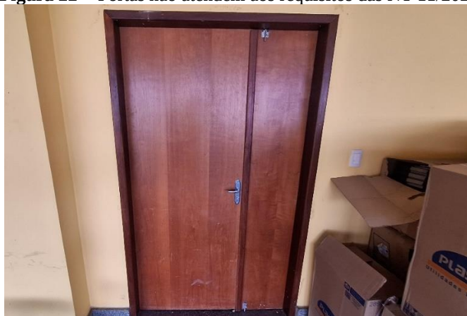
Figura 22 - Portas não atendem aos requisitos das NT 11/2021
