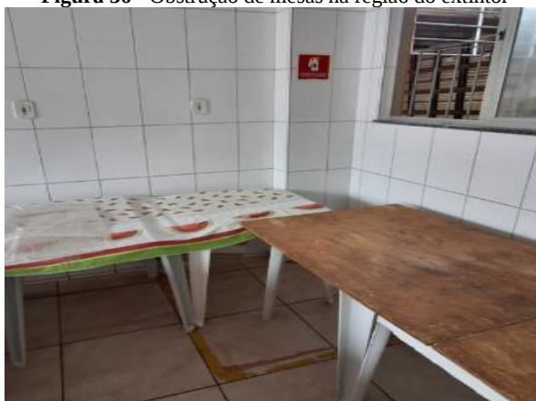
Figura 36 - Obstrução de mesas na região do extintor
