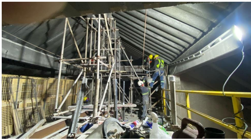
Figura 11 - Execução de grauteamento de pilar
