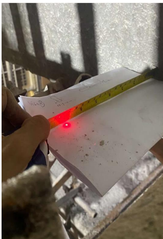
Figura 7 – Medição do desaprumo da Viga Pórtico 01 realizada com equipamento a laser.
