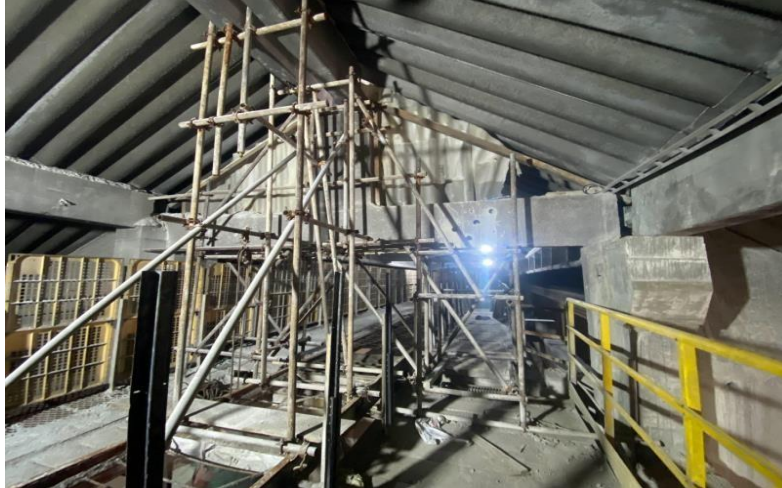
Figura 13 – Sistema de escoramento adotado do tipo tubo roll para a execução da recuperação estrutural da Viga Pórtico 01.
