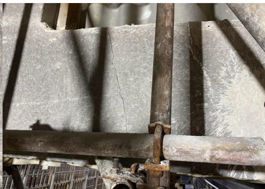
Figura 5 – (a) Fissuração da Viga Pórtico 01 próximo ao encontro com pilar e (b) Fissuração da Viga Pórtico 01
