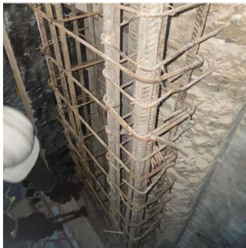
Figura 10 – Armaduras do pilar Pórtico 01 após a reconstrução e reforço estrutural.
