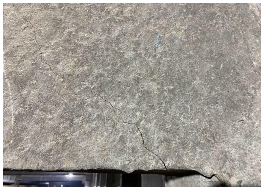
Figura 5 – (a) Fissuração da Viga Pórtico 01 próximo ao encontro com pilar e (b) Fissuração da Viga Pórtico 01
