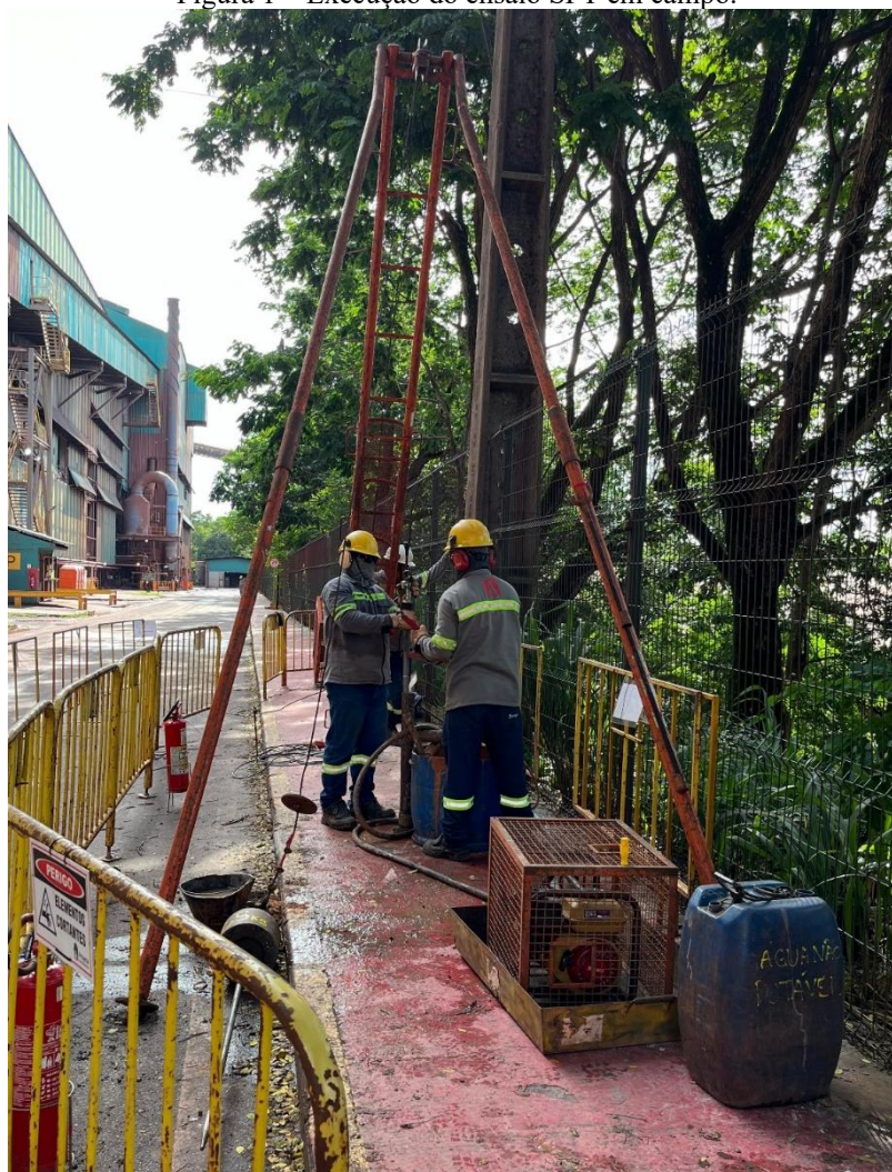
Figura 1 – Execução do ensaio SPT em campo.
