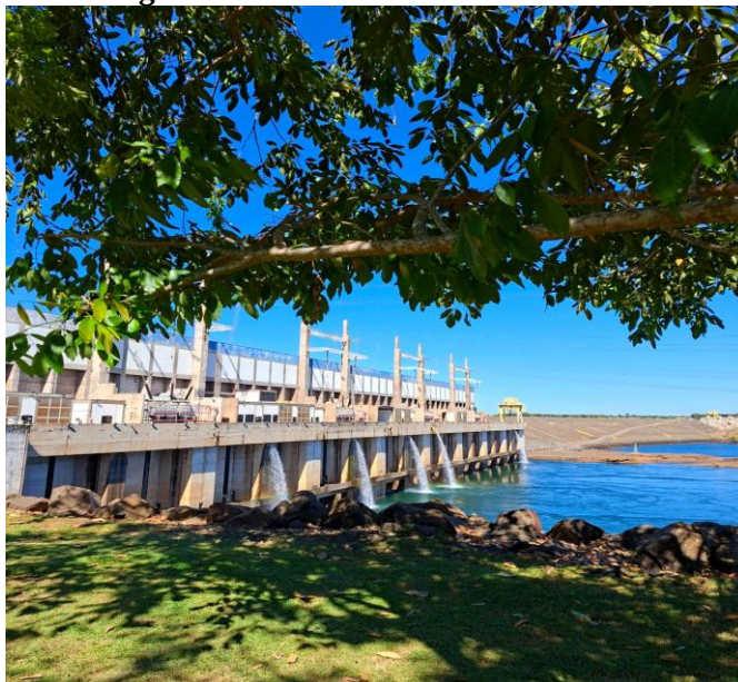
Figura 8: Usina Hidrelétrica de Estreito.
