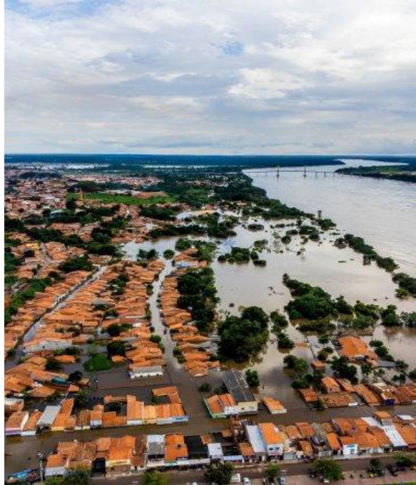
Figura 7: Enchente do Rio Tocantins no Bairro Beira Rio, Imperatriz – MA.
