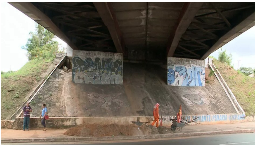
Figura 1 – Viaduto do Café antes da reforma
