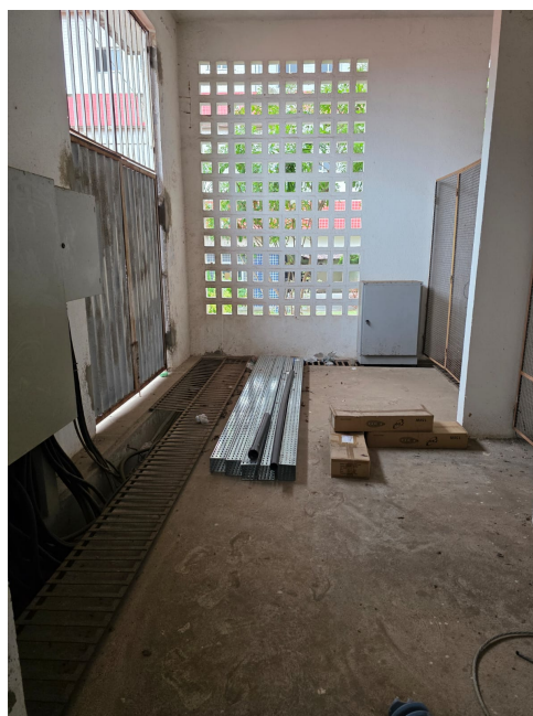
Figura 5.7 – Materiais obstruindo a circulação.
