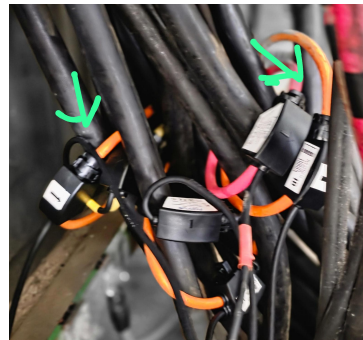
Figura 5.2 – Instalação sensores de corrente.
