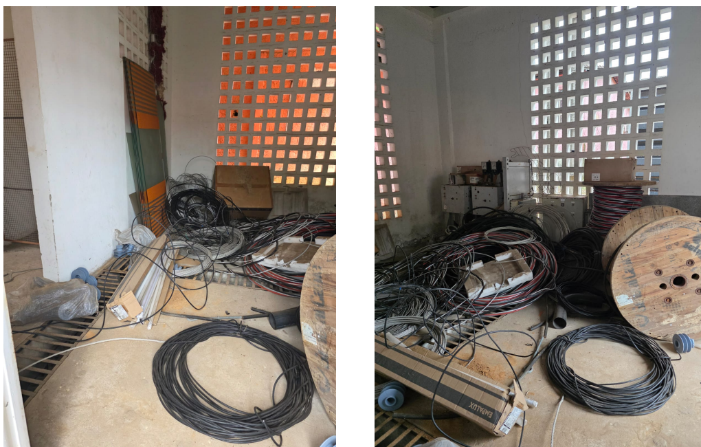
Figura 5.6 – Ambiente interno de subestação utilizado como depósito.
