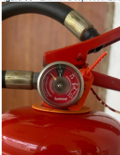
Figura 35 - Extintor Despressurizado
