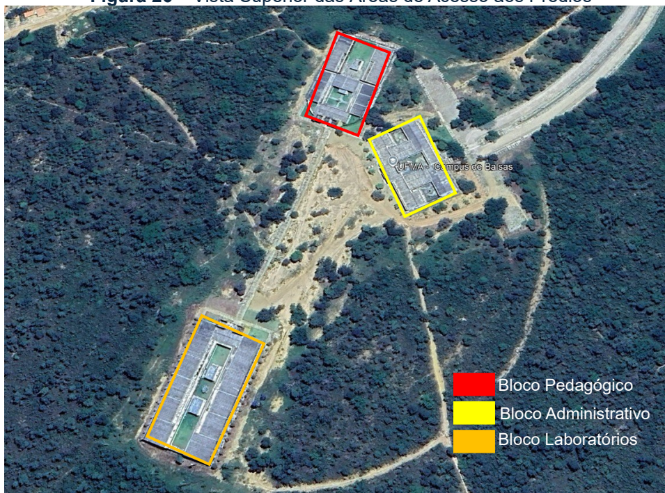
Figura 26 – Vista Superior das Áreas de Acesso aos Prédios
