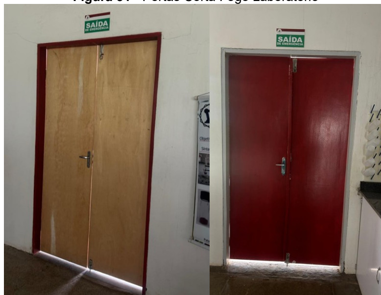
Figura 31 - Portas Corta Fogo Laboratório
