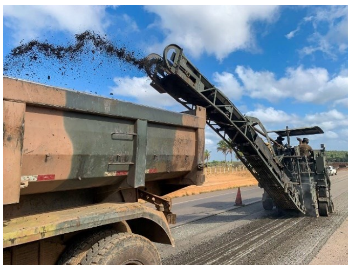
Figura 13: Processo de fresagem do revestimento asfáltico.
