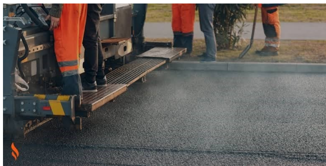
Figura 14: Recapeamento com mistura asfáltica usinada.
