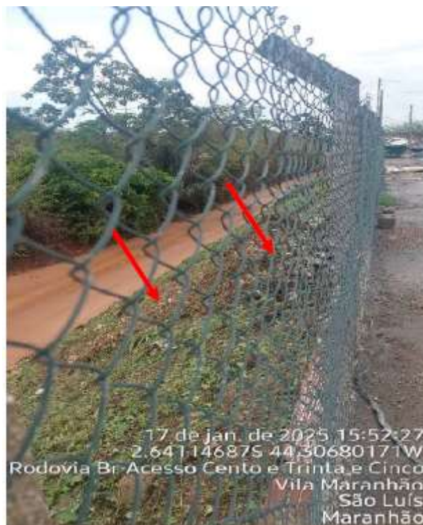
Figura 24: Talude presente no local de estudo.
