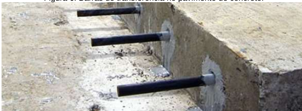
Figura 6: Barras de transferência no pavimento de concreto.
