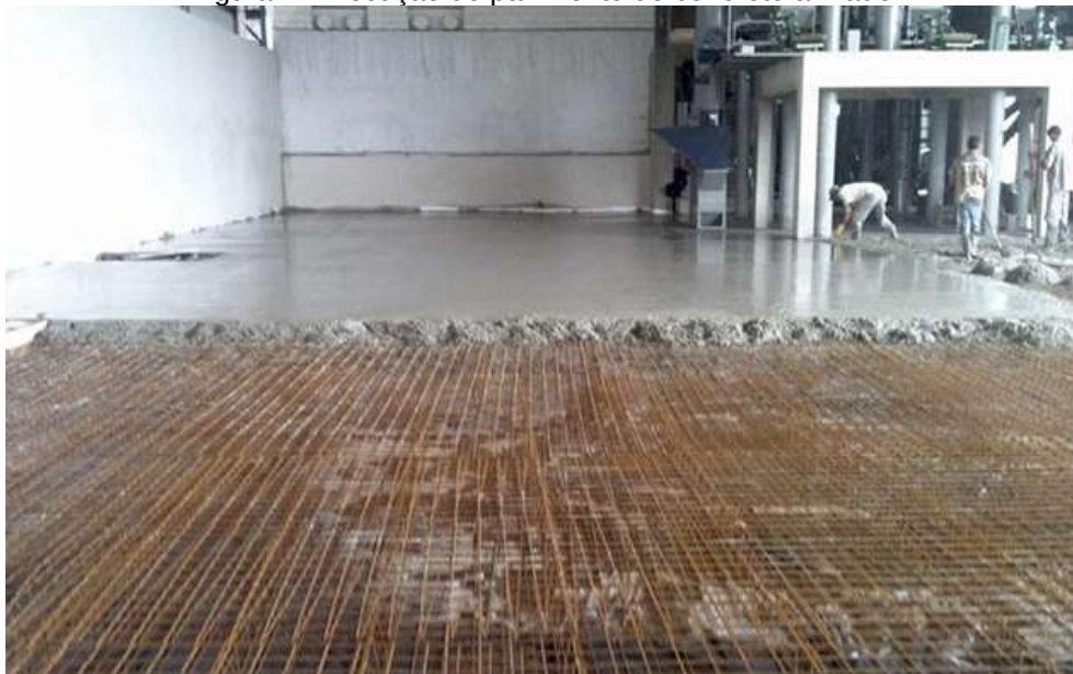
Figura 2: Execução de pavimento de concreto armado.
