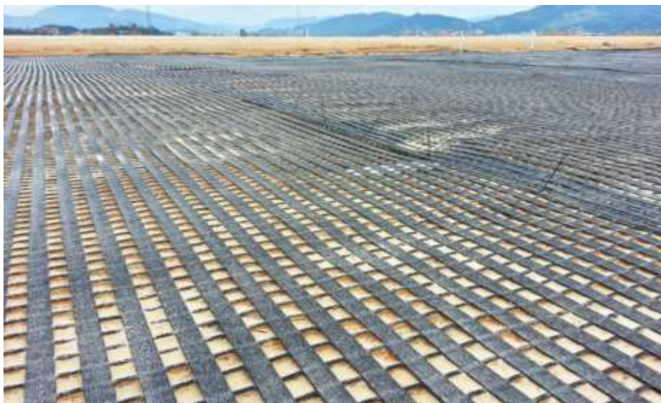
Figura 15: Reforço com geossintéticos ou fibras poliméricas.
