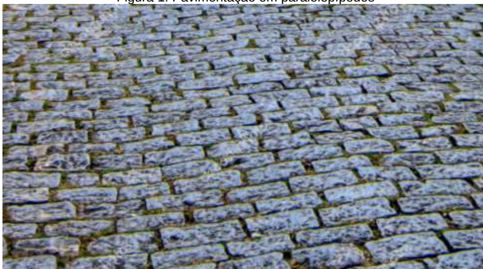
Figura 1: Pavimentação em paralelepípedos
