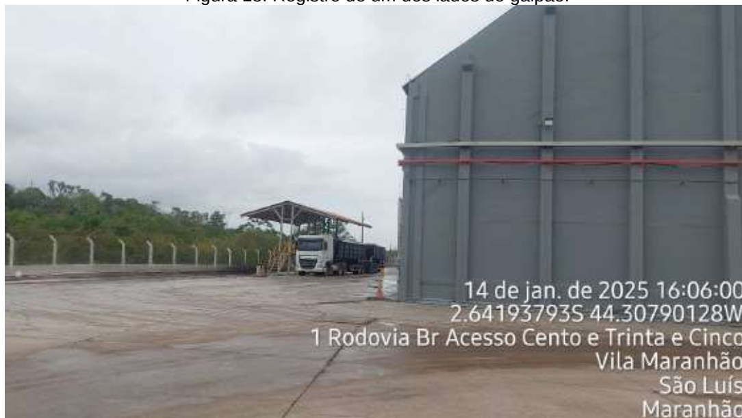
Figura 18: Registro de um dos lados do galpão.
