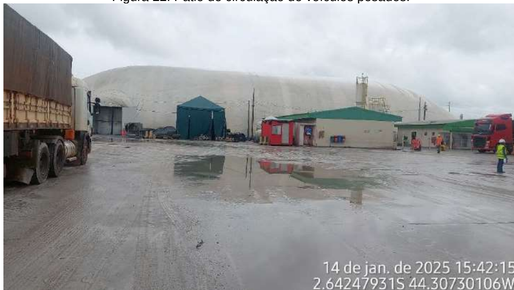
Figura 22: Pátio de circulação de veículos pesados.
