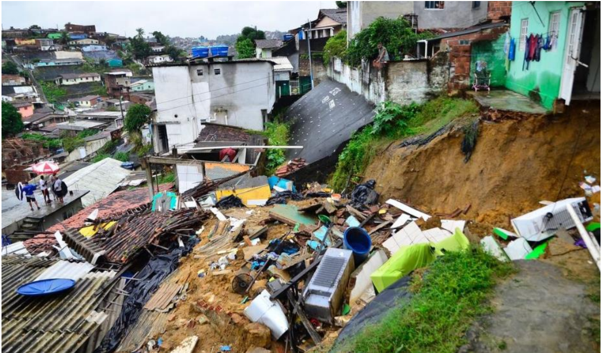
Figura 3 - Encostas urbanas em Recife (PE), evidenciando áreas suscetíveis a deslizamentos e intervenções de estabilização.
