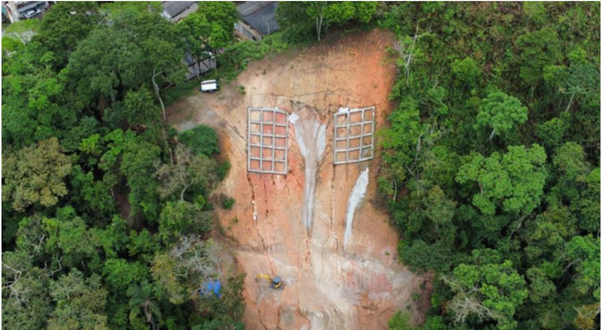
Figura 12 - Corte de encosta sem critérios técnicos, solo exposto, ocupação próxima ao talude e potencial risco de deslizamento.
