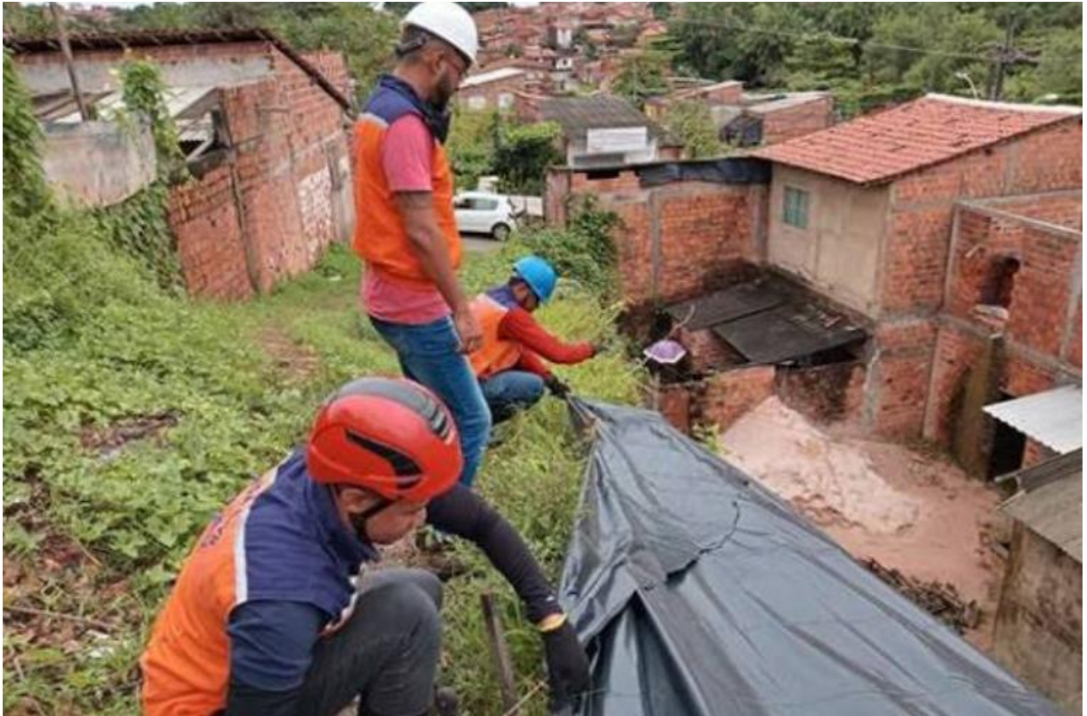
Figura 5 - Área de risco no município de São Luís (MA), evidenciando ocupação em encosta e suscetibilidade a processos erosivos e deslizamentos.
