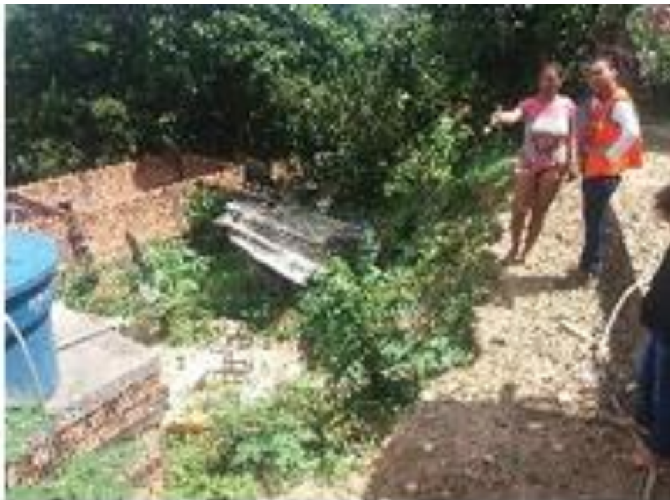
Figura 9 - Deslizamentos no Bairro Vila Embratel no município de São Luís (MA)
