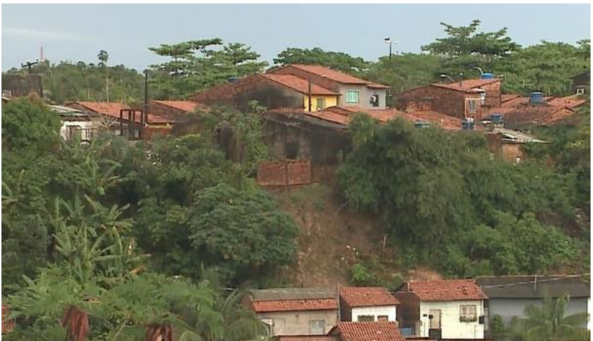
Figura 6 - Área de risco no município de São Luís (MA), evidenciando ocupação em encosta e suscetibilidade a processos erosivos e deslizamentos.
