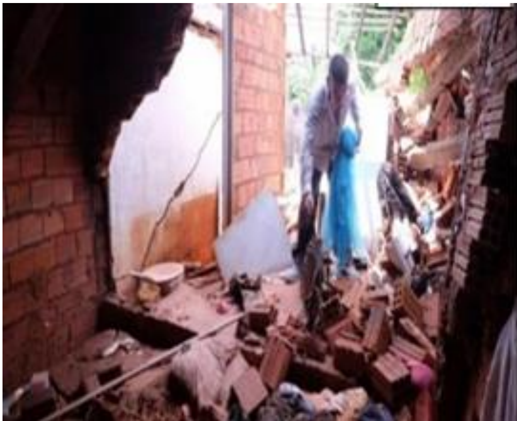
Figura 11 - Deslizamentos no Bairro Sacavém no município de São Luís (MA).
