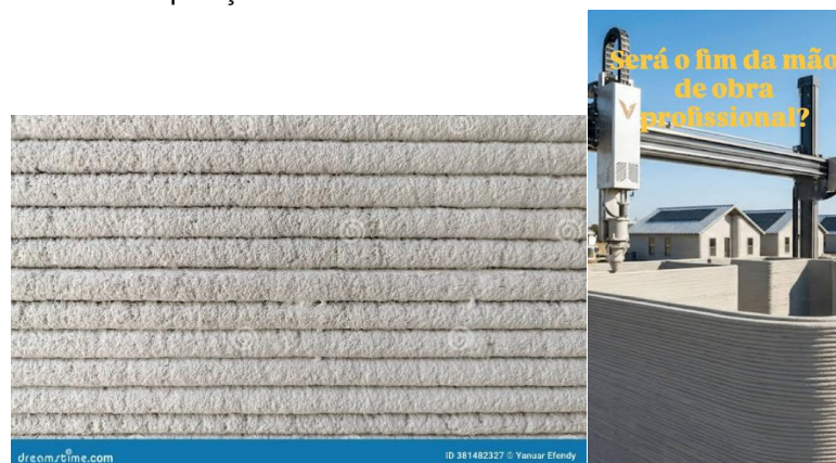
Figura 4 – Detalhe da deposição de camadas de mistura cimentícia sem colapso estrutural
