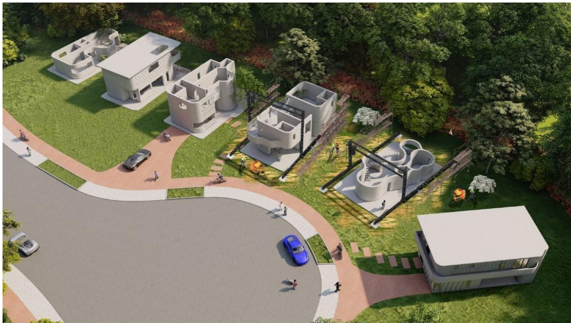
Figura 6 – Canteiro de obras de impressão 3D evidenciando a ausência de fôrmas e entulhos
