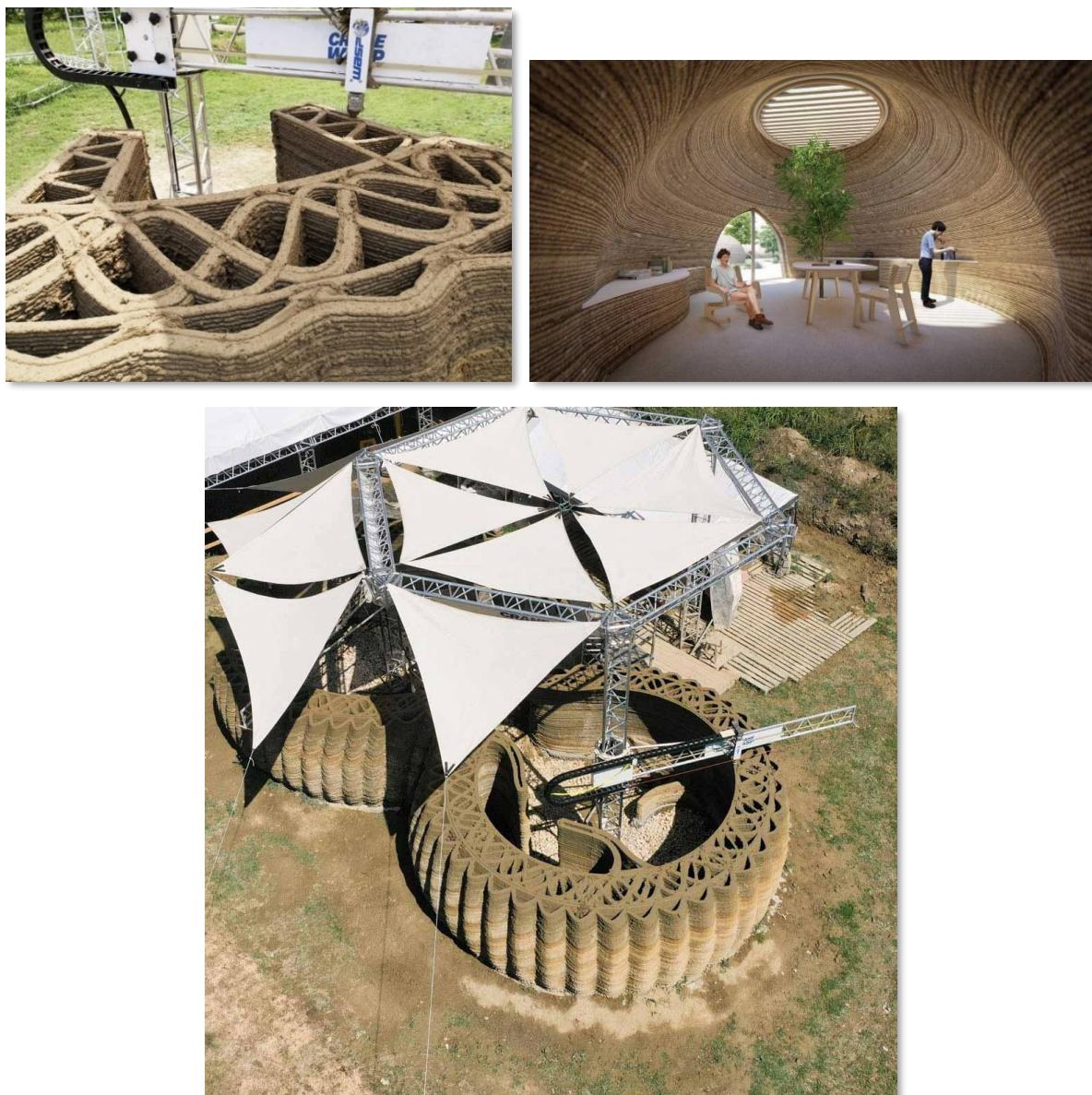
Figura 11 - Projeto TECLA (Itália): habitação impressa em 3D que utiliza terra local crua e resíduos agrícolas, eliminando, nesse projeto, o uso de cimento e fôrmas.
