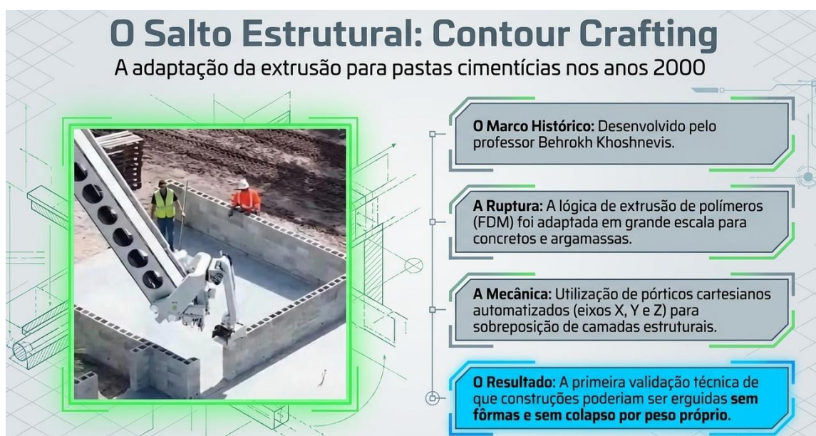
Figura 3 – Tecnologia Contour Crafting e extrusão de concreto
