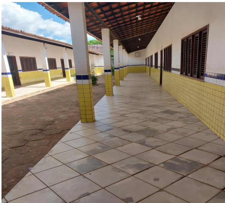
Figura 3 – Corredor de acesso às salas de aula da escola
