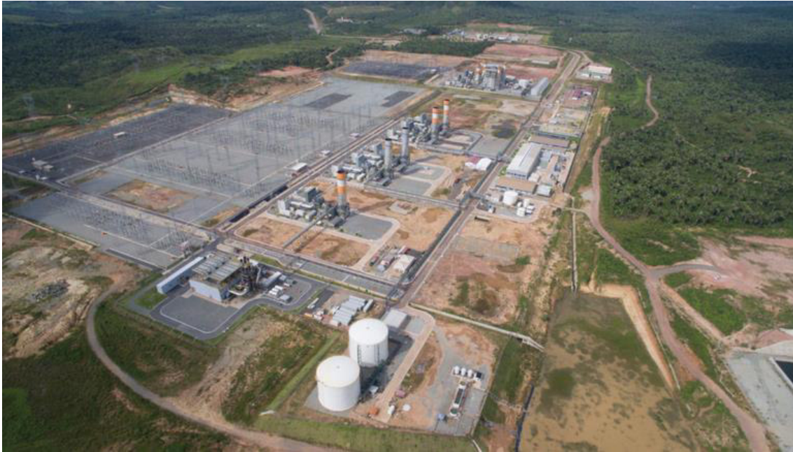
Figura 2: área da Usina amostrada Termelétrica (Complexo Parnaíba III), Santo Antônio dos Lopes-MA. Fonte: http://www.businessreviewbrasil.com.br/1%C3%ADdereempresariais/370/Eneva-inicia-operaccedilatildeo-da-usina-termeleacutetrica-Parnaiaacuteba-IV 2017
