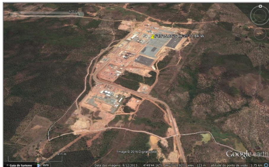
Figura 2 - Complexo Parnaíba, formado pelas usinas Termelétricas Parnaíba I, Parnaíba II, Parnaíba III e Parnaíba IV.
