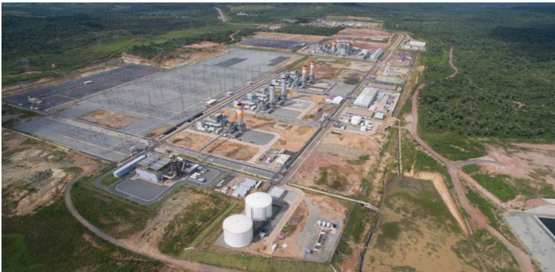
Figura 2. Área da Usina Termelétrica ENEVA (Complexo Parnaíba III), Santo Antônio dos Lopes-MA. Fonte: https://ejatlas.org/conflict/thermoelectric-complex-parnaiba
