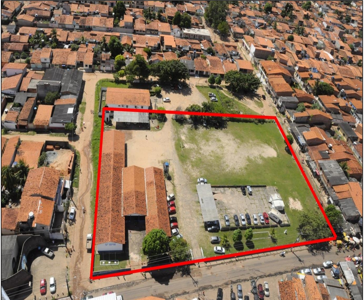
Figura 1 – Imagem aérea das instalações do 6º BPM.
