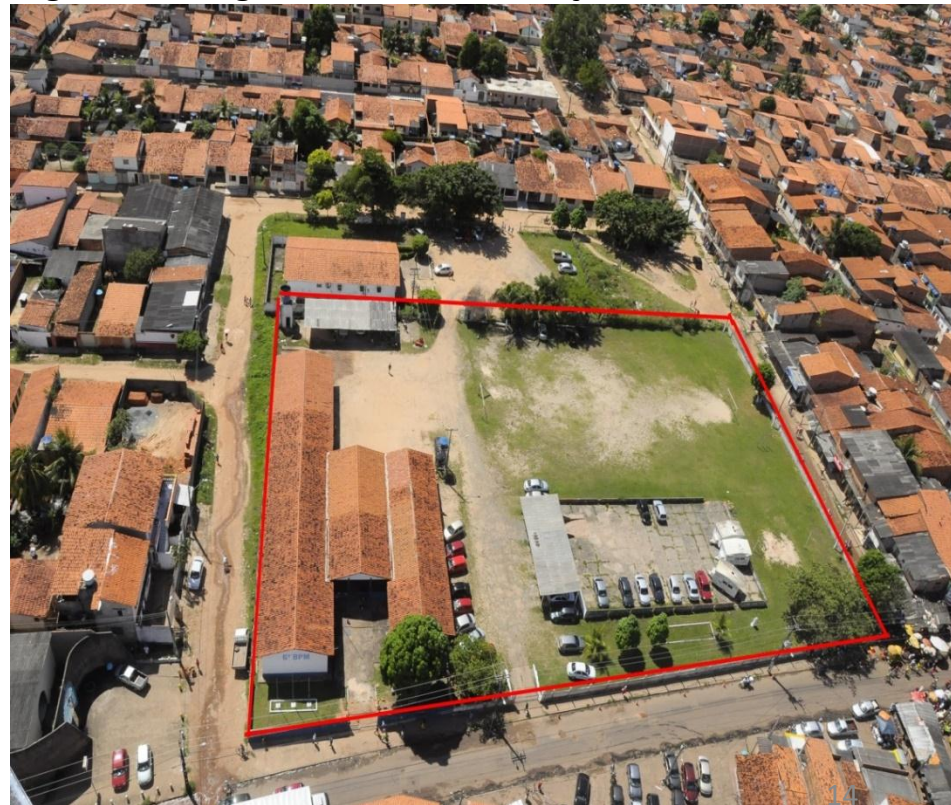
Figura 1 – Imagem aérea das instalações do 6º BPM.
