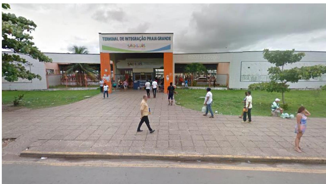
Figura 8 - Parte externa do Terminal da Praia Grande.
