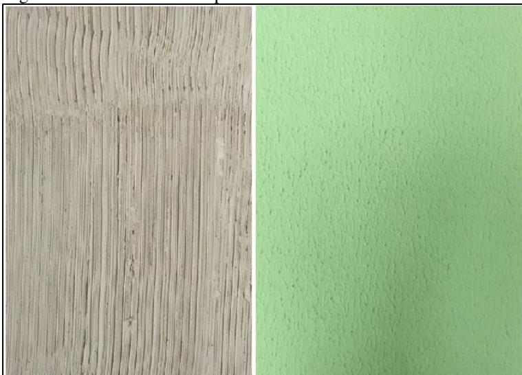
Figura 29 - Textura e cor de paredes
