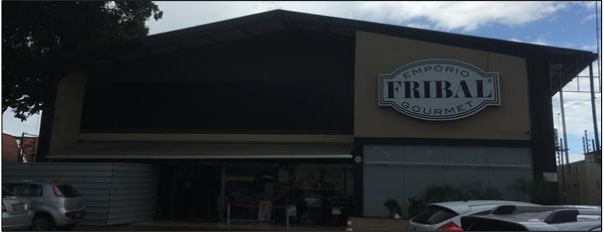
Figura 40 - Fachada do estabelecimento
