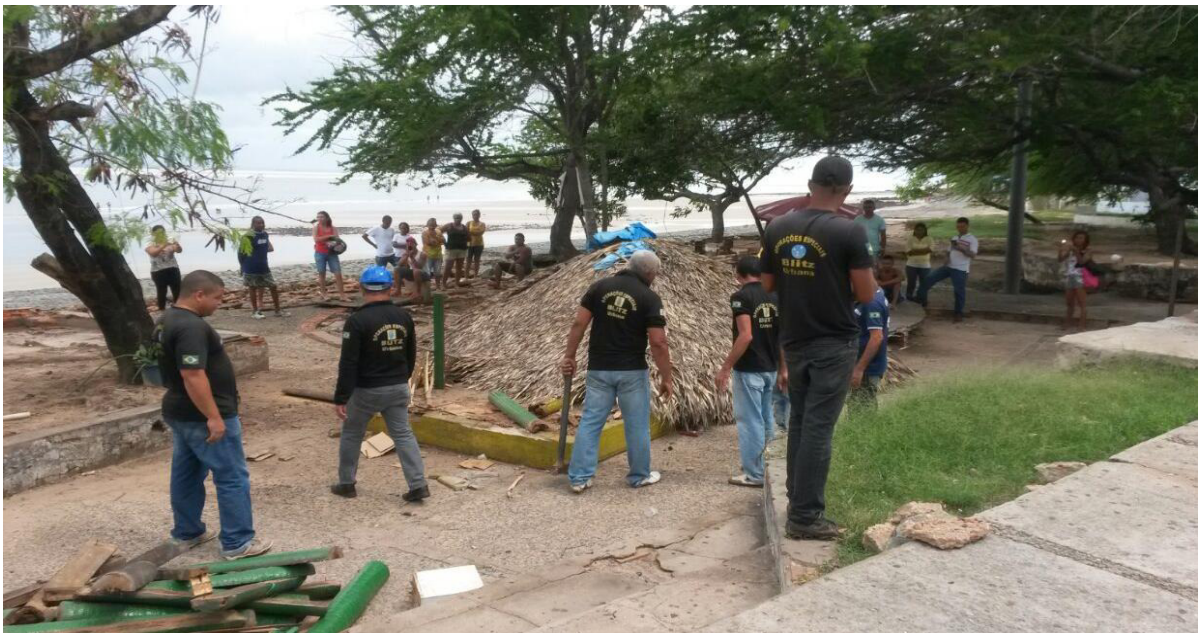
Foto 01 – Ação de demolição de edificação irregular
