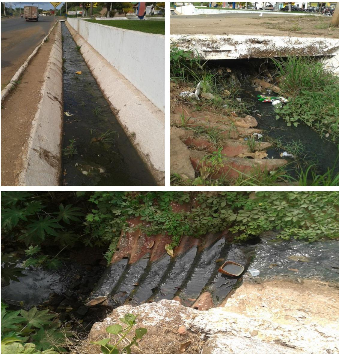
**Figura 3.** Esgotos de atividade comercial e doméstica drenado por calha e canal artificial até o rio debaixo da ponte de cimento no centro de Grajaú.
