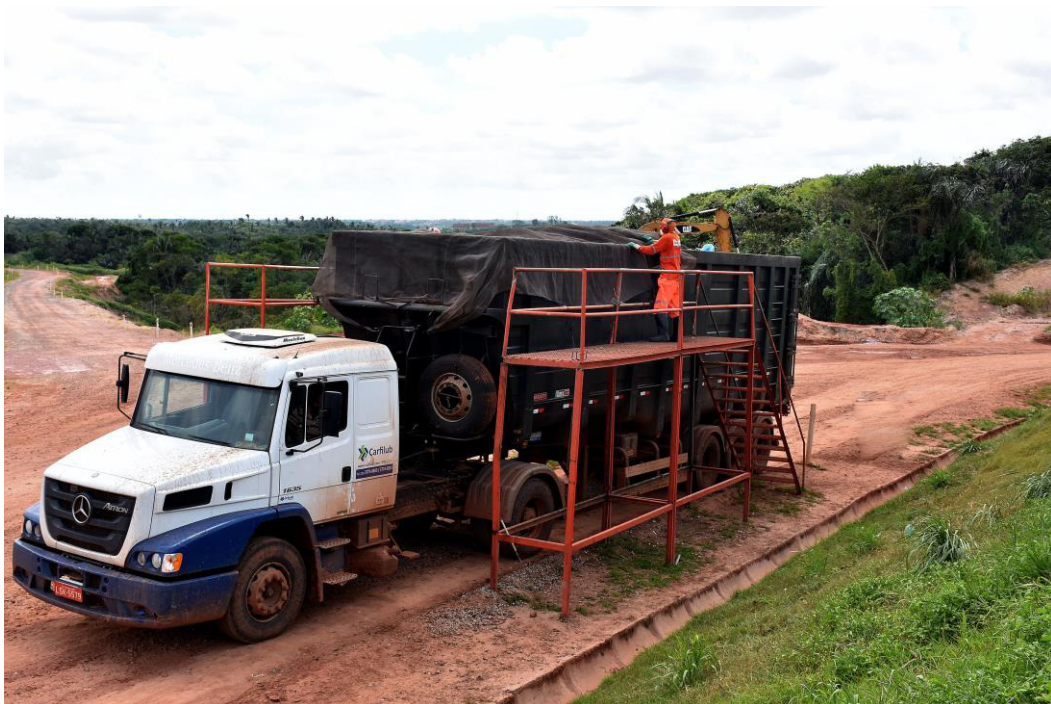
Fotografia 5 – Funcionários colocando uma lona para maior segurança no transporte.
