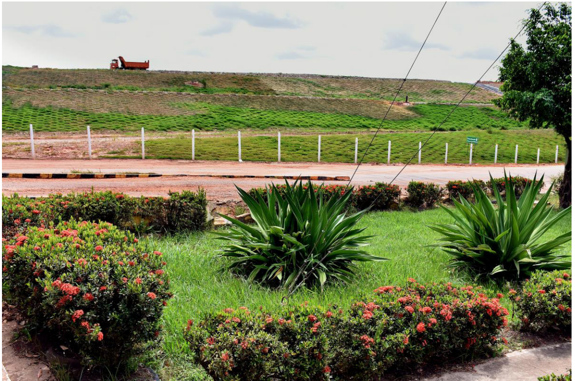
Fotografia 1 – Aterro da Ribeira após recuperação ambiental.
