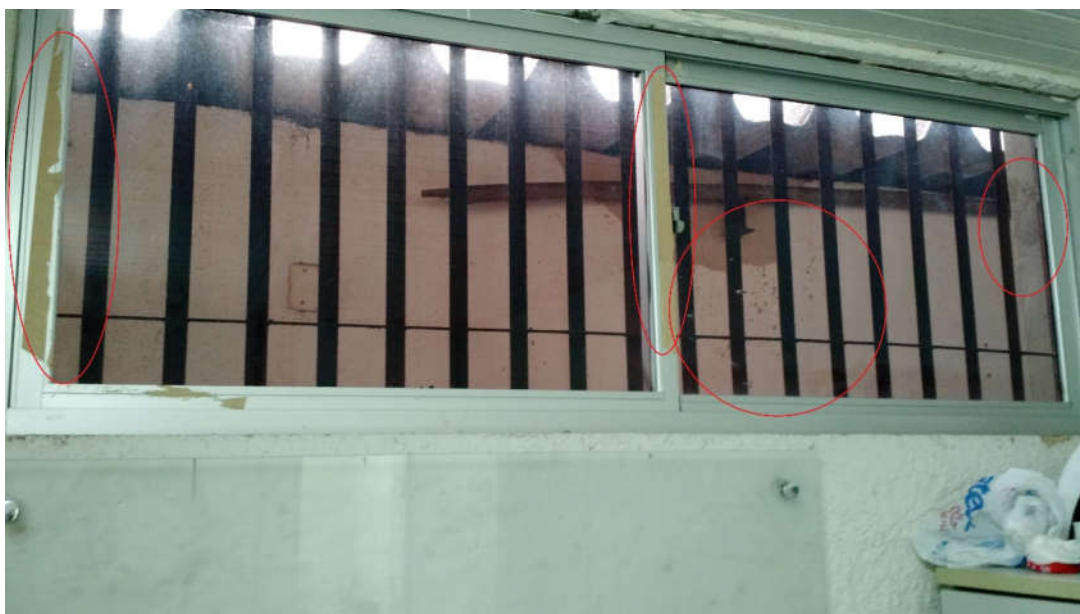
Fotografia 67 – Janela da Sala 02
