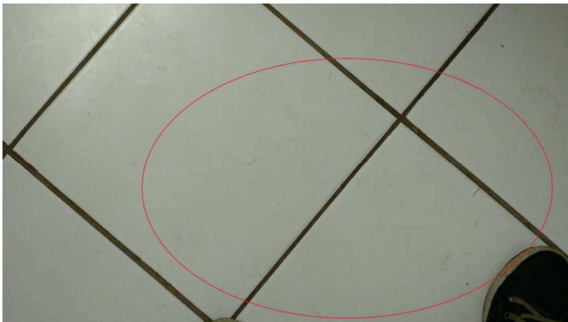
Fotografia 84 – Visão 1 do Chão da Sala 02
