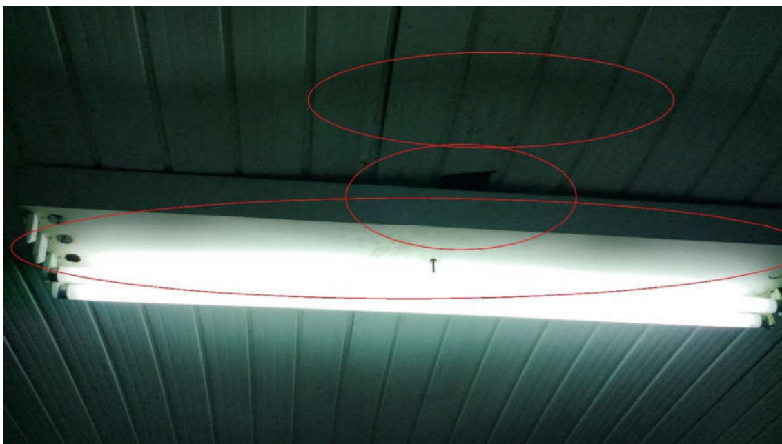
Fotografia 83 – Teto e suporte de lâmpadas da Sala 02
