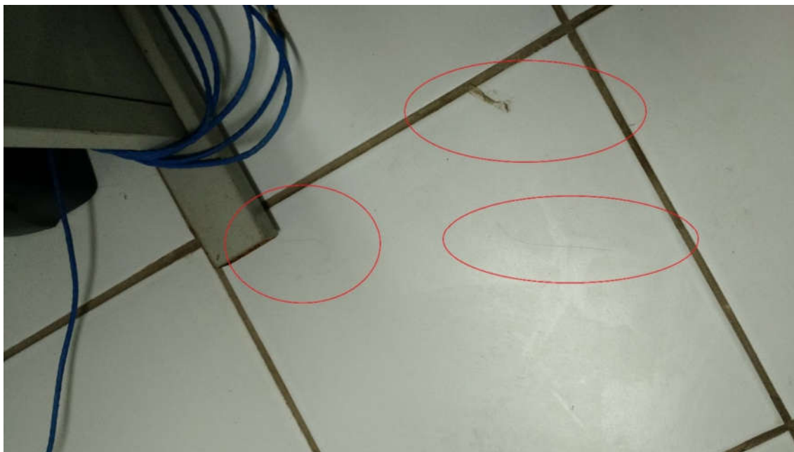
Fotografia 85 – Visão 2 do Chão da Sala 02
