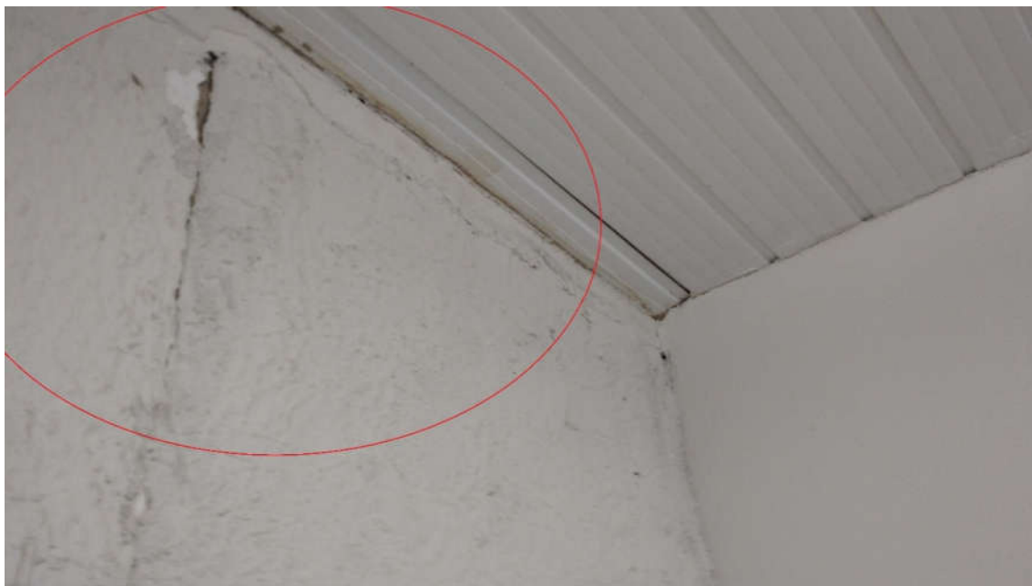
Fotografia 33 – Parede da Sala 01
