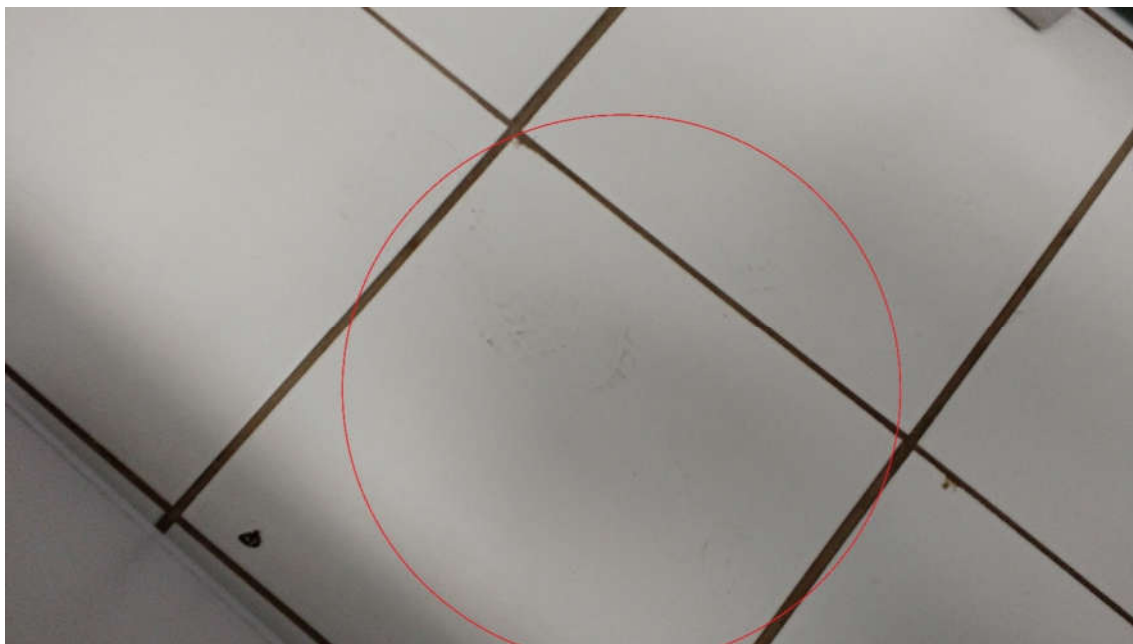
Fotografia 38 – Visão 3 do chão da Sala 01
