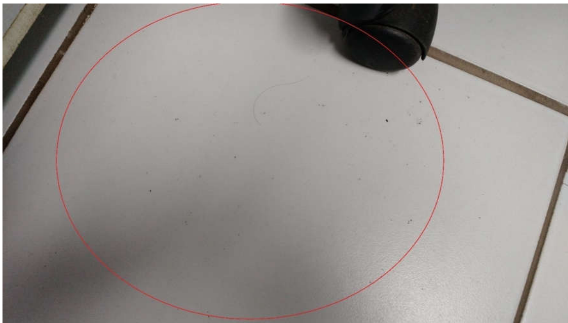
Fotografia 36 – Visão 1 do chão da Sala 01
