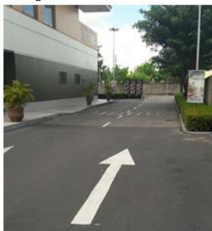
Figura 12: Entrada do drive-thru
