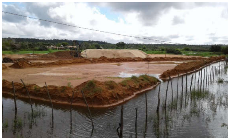
Figura 01 - Aterro às margens rio Buriti (período de cheia) para a construção do Balneário do Rio Buriti.
