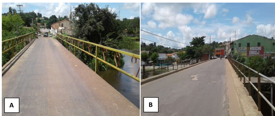
A – Ponte antiga sobre o rio Buriti; B - Ponte atual sobre o Rio Buriti
