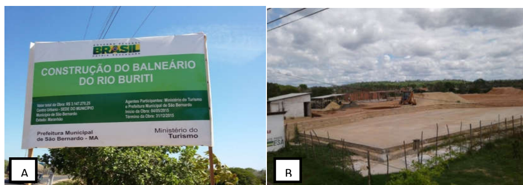
Figura 13 – (A e B) - Valor estimado (placa) e situação atual da obra para a construção do Balneário do Rio Buriti.
