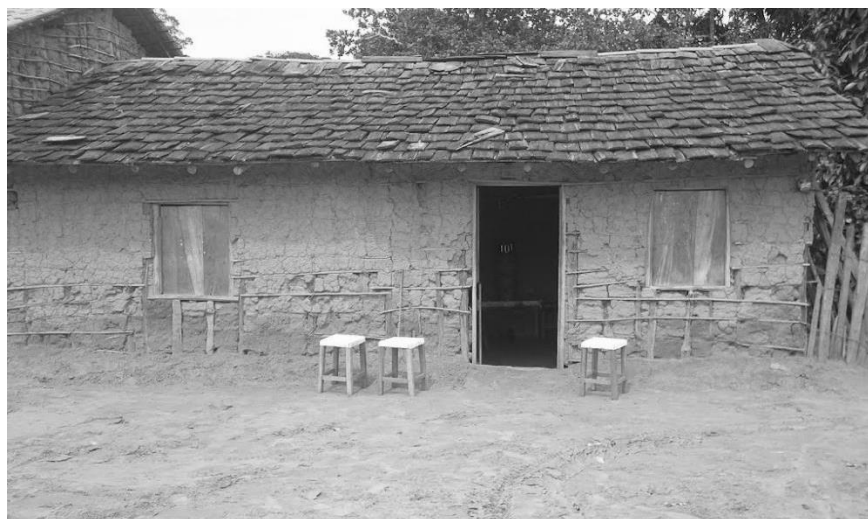
Figura 08 – Exemplo de casa de barro coberta com cavaco, nos dias atuais, no município de Barra do Corda, Maranhão.
