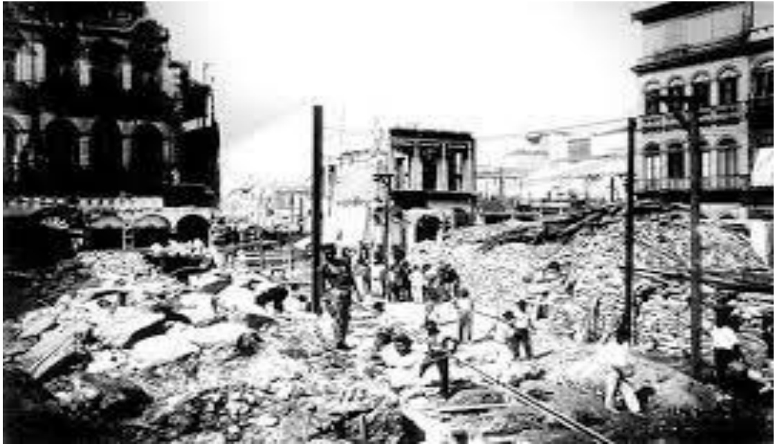
Figura 2 - Obras para abertura da avenida central 1904. Esta impressionante imagem mostra o caos que se transformou o centro do Rio no período da desapropriação e demolição do antigo casario para a construção da avenida central (Atual Avenida Rio Branco).
