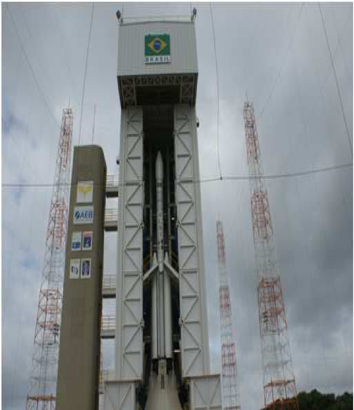
Imagem 08 – Nova Torre de Lançamento do VLS -1
