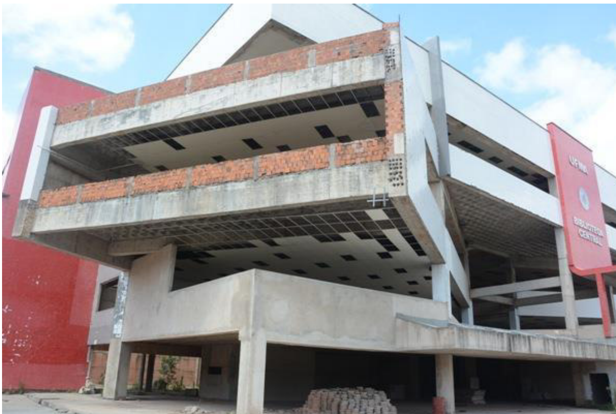
Figura 2- Obra da Biblioteca Central da UFMA.
