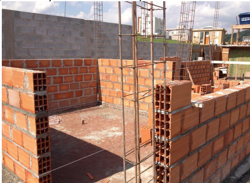
Figura 4: Execução de alvenaria de vedação em bloco cerâmico com 9 furos
