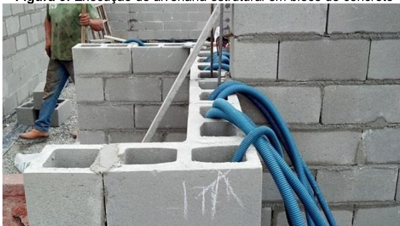
Figura 3: Execução de alvenaria estrutural em bloco de concreto
