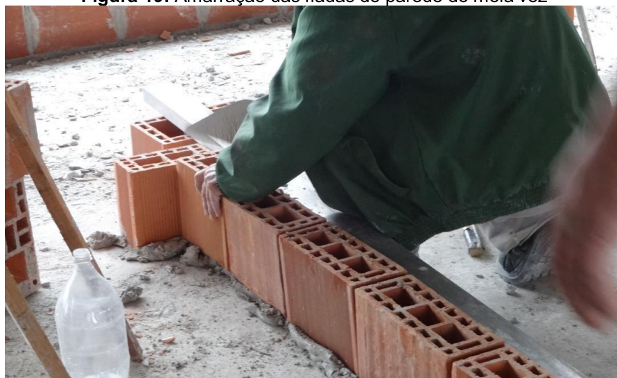
Figura 19: Amarração das fiadas de parede de meia vez
