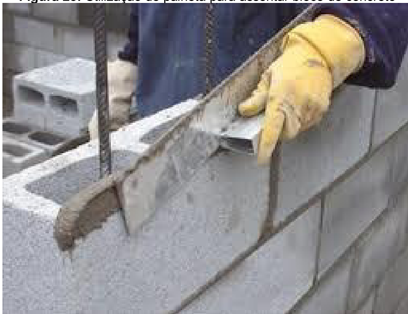
Figura 23: Utilização de palheta para assentar bloco de concreto
