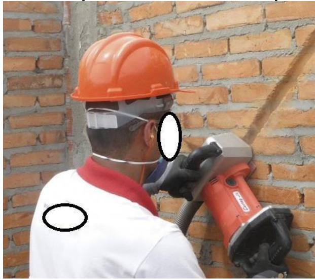
Figura 105: Execução de corte em alvenaria com tijolo cerâmico
