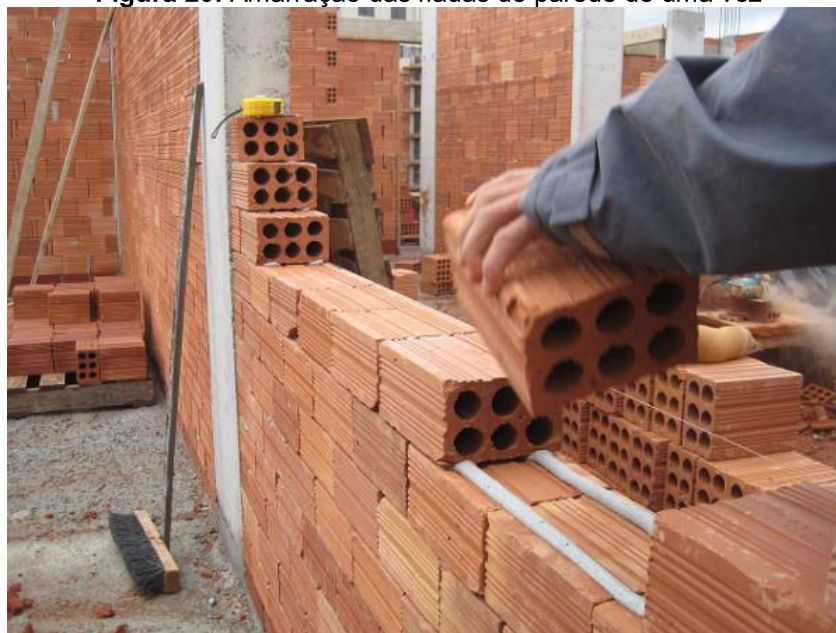
Figura 20: Amarração das fiadas de parede de uma vez
