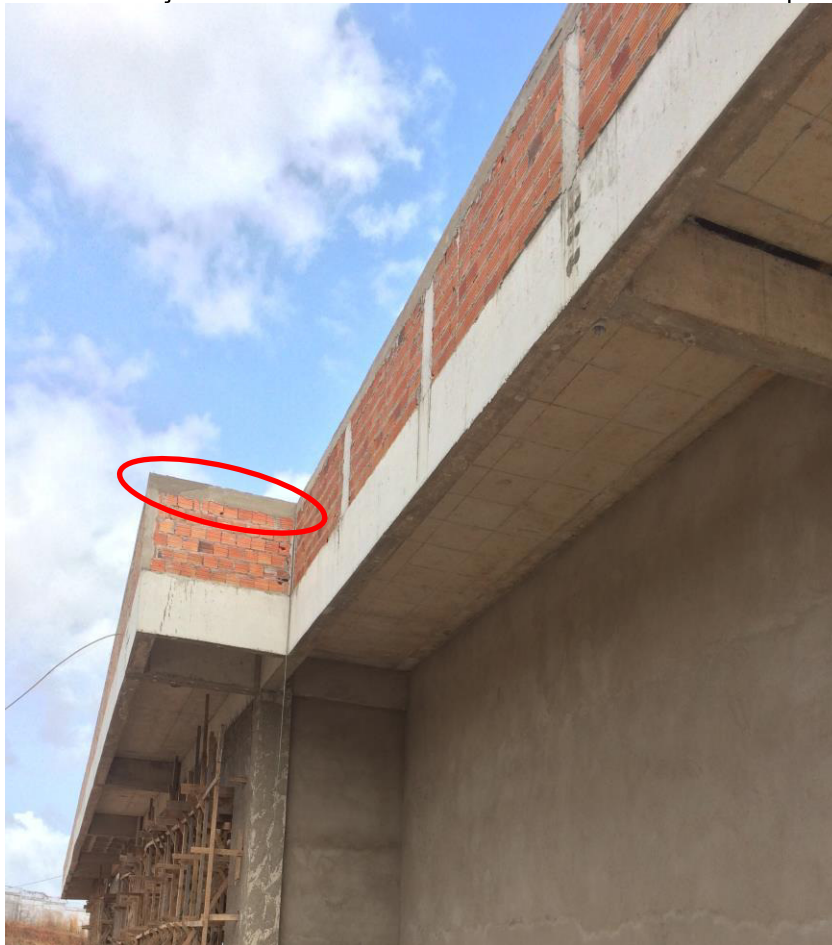
Figura 45: Execução de cinta de travamento em concreto armado em parapeito
