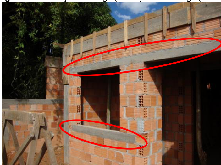
Figura 44: Execução de verga (acima) e contraverga (abaixo)
