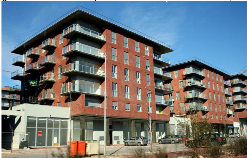
Figura 8: Modelo de edificação com alvenaria de bloco cerâmico aparente
