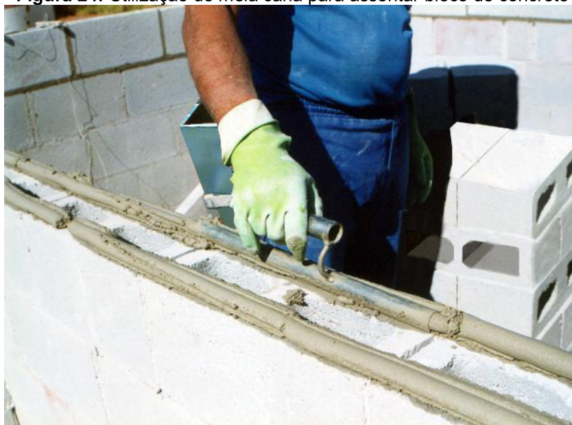
Figura 24: Utilização de meia cana para assentar bloco de concreto
