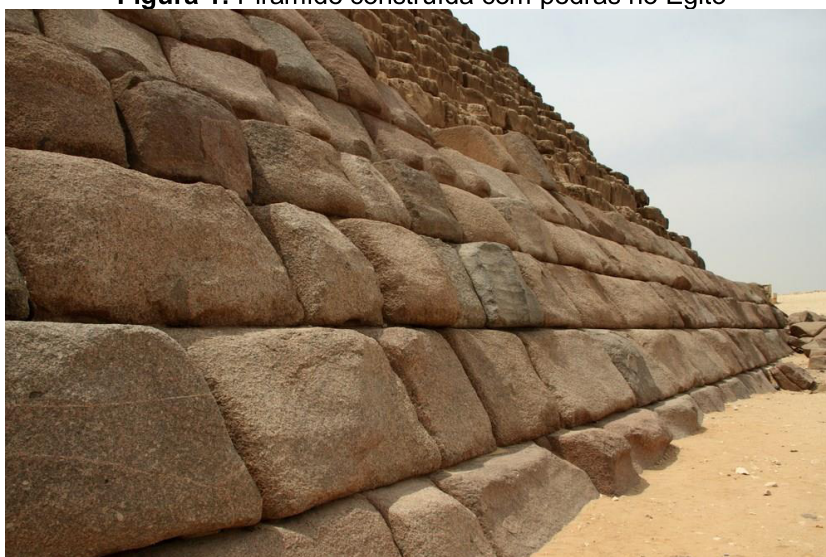
Figura 1: Pirâmide construída com pedras no Egito
