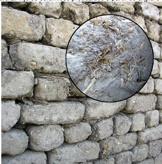
Figura 2: Tijolos cerâmicos produzidos a partir de argila e palha
