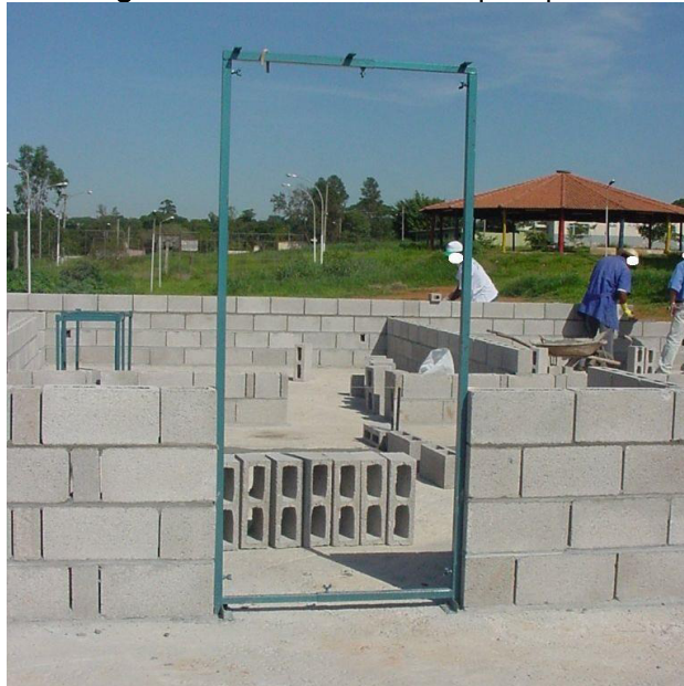
Figura 43: Gabarito metálico para porta
