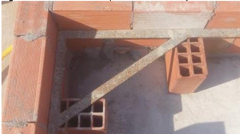
Figura 65: Conferência de esquadro durante execução de alvenaria
