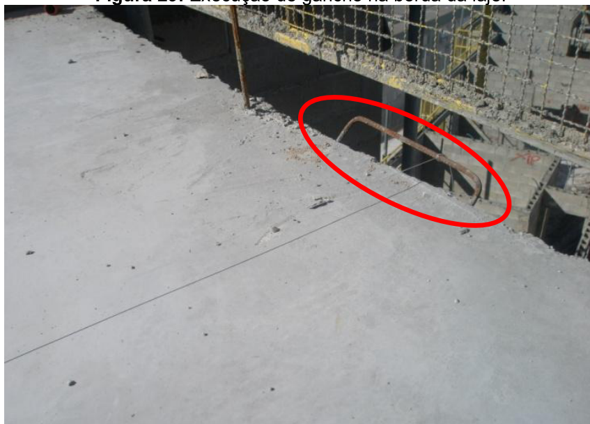
Figura 29: Execução de gancho na borda da laje.
