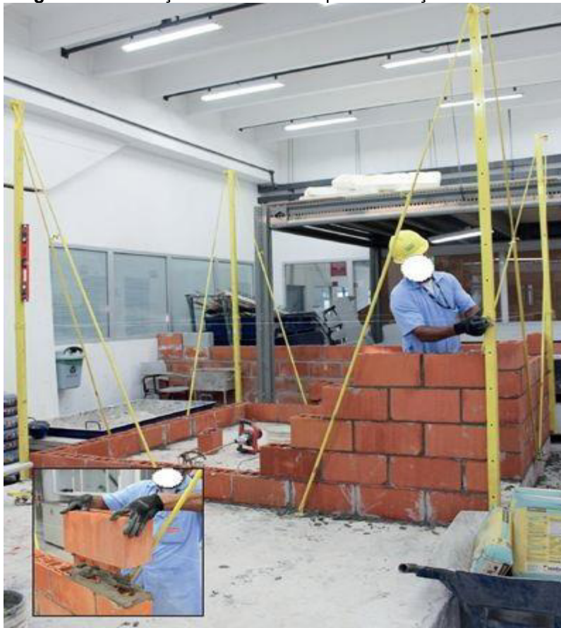
Figura 21: Utilização de escantilhão para execução de alvenaria
