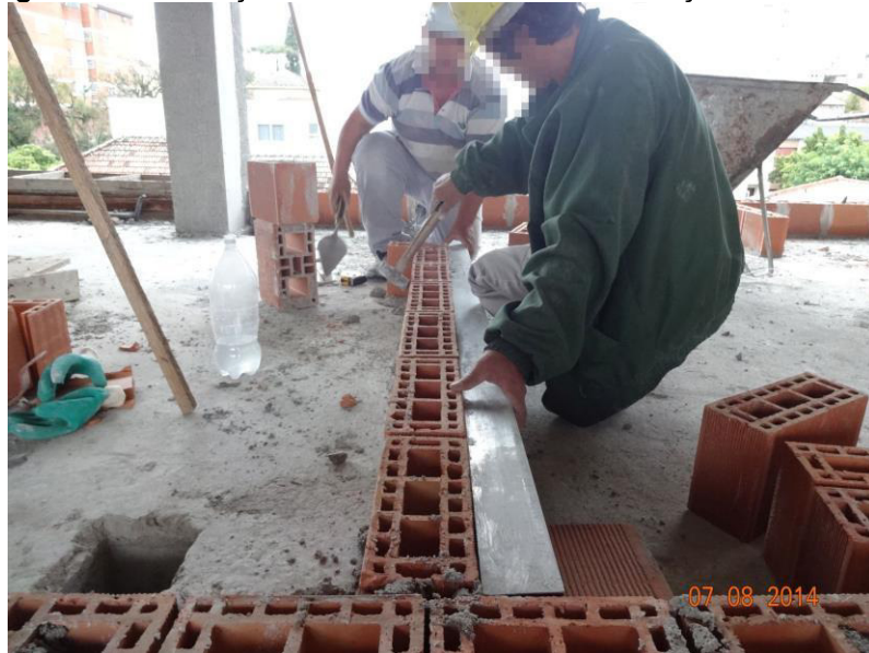
Figura 64: Verificação de alinhamento durante execução de alvenaria
