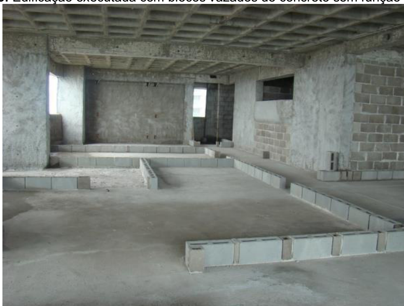
Figura 5: Edificação executada com blocos vazados de concreto sem função estrutural
