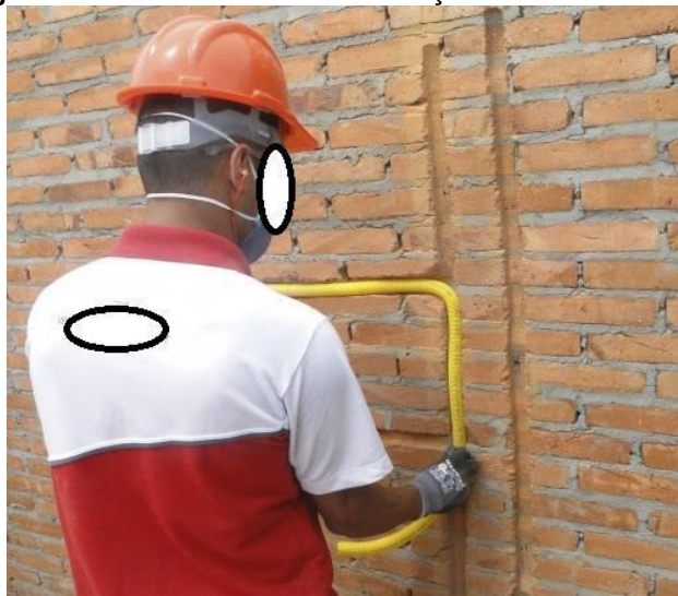
Figura 106: Embutimento de instalações elétricas no rasgo
