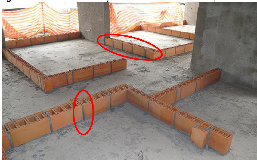
Figura 36: Preenchimento de juntas verticais dos blocos da primeira fiada
