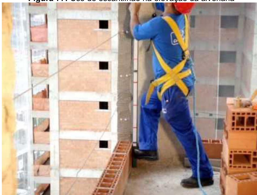
Figura 77: Uso de escantilhão na elevação da alvenaria
