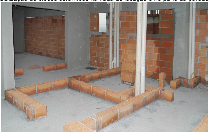
Figura 30: Utilização de blocos cerâmicos na fiada de locação e no pano da parede de alvenaria
