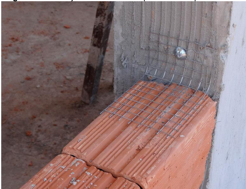
Figura 40: Instalação de tela metálica para conexão pilar-alvenaria
