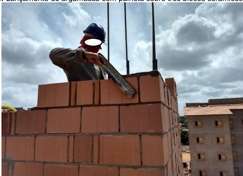
Figura 78: Lançamento de argamassa com palheta sobre três blocos cerâmicos estruturais
