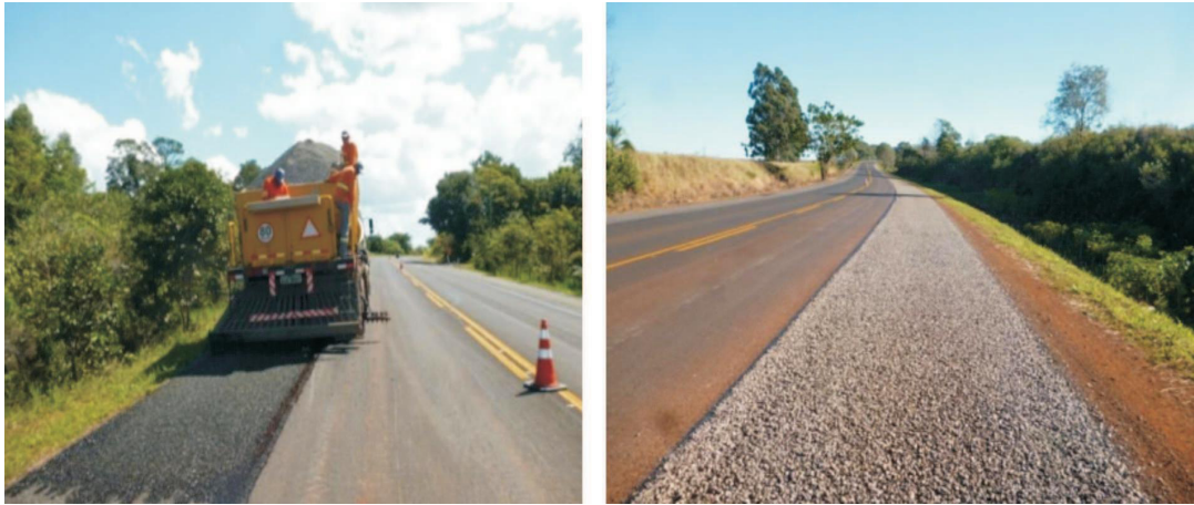
Figura 27 – Aplicação de tratamento superficial duplo na BR 468/RS
