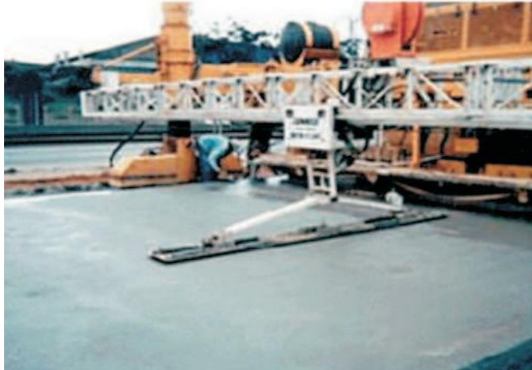
Figura 6 – Pavimentação rígida com placas de concreto
