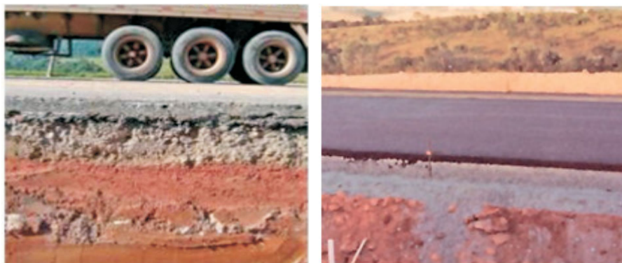
Figura 20 – Exemplos de Pavimento novo com Revestimento Asfáltico
