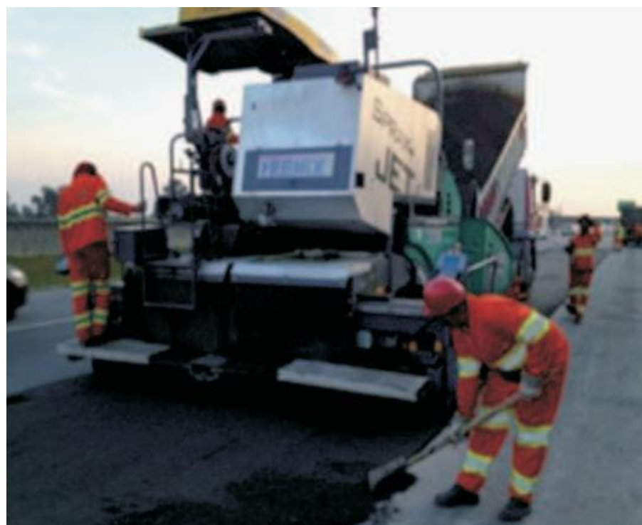
Figura 25 – Reciclagem in situ com espuma de asfalto
