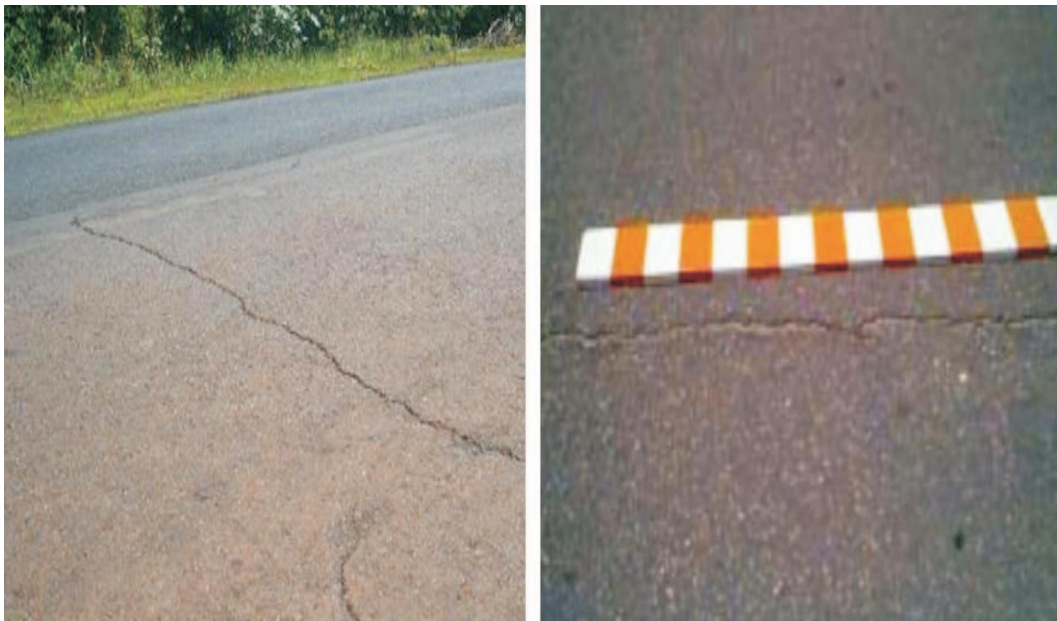
Figura 28 – Fendas transversais
