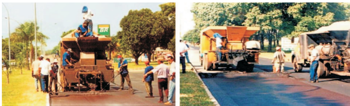
Figura 22 – Aplicação de lama asfáltica em um trecho de via urbana
