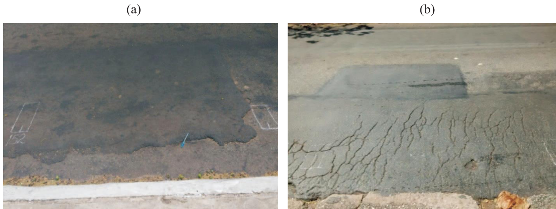
Figura 59 – (a) Remendo trincado e (b) ondulado nas estações 142 e 167, respectivamente
