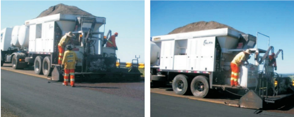
Figura 23 – Aplicação de microrrevestimento como restauração funcional em rodovia
