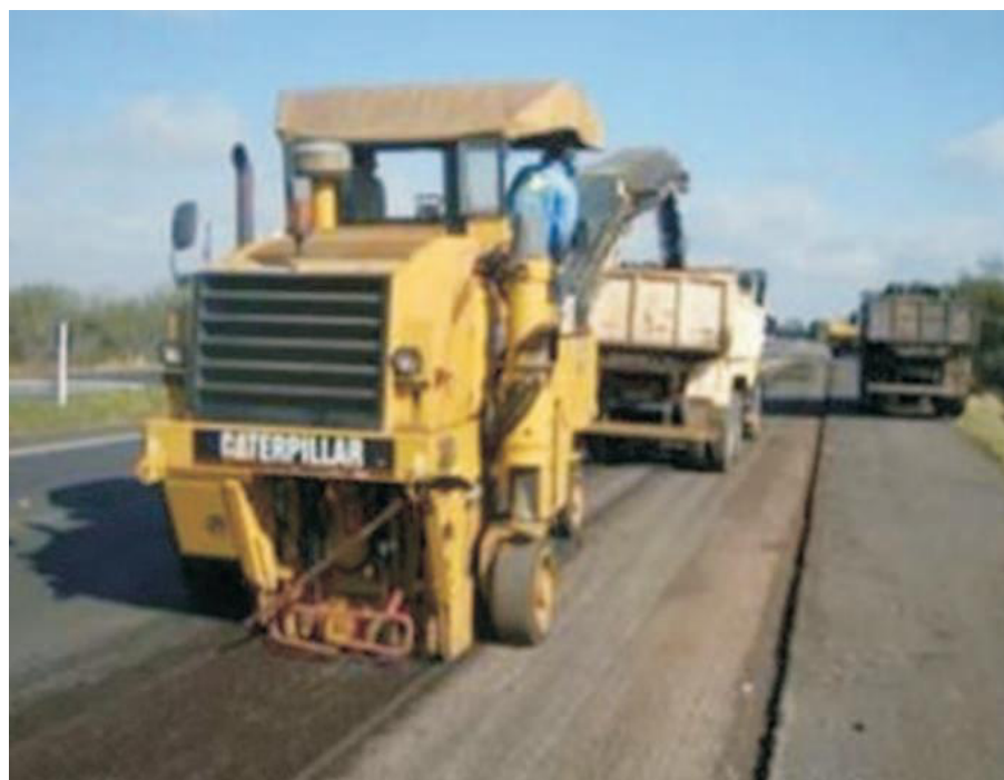
Figura 24 – Processo de fresagem à frio de um pavimento
