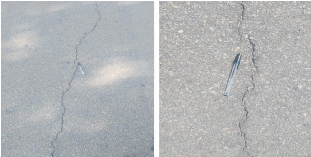
Figura 29 – Fendas longitudinais
