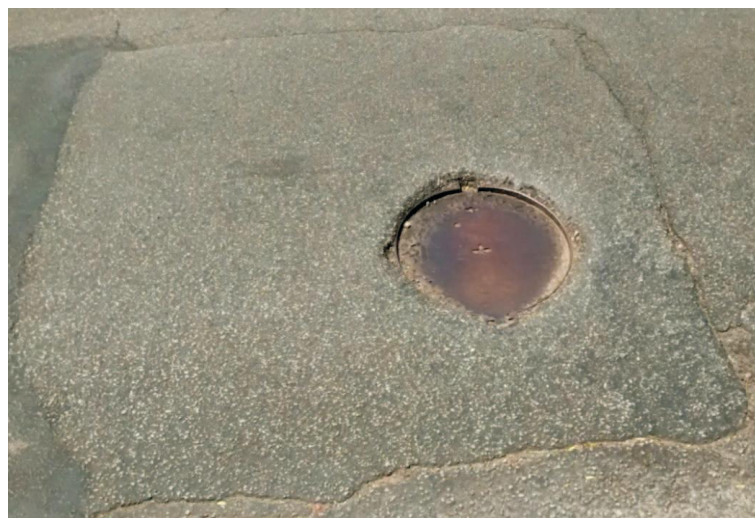
Figura 60 – Remendo de intervenção em rede subterrânea na estação 111
