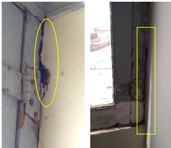
Figura 55 - Descolamento esquadria/parede
