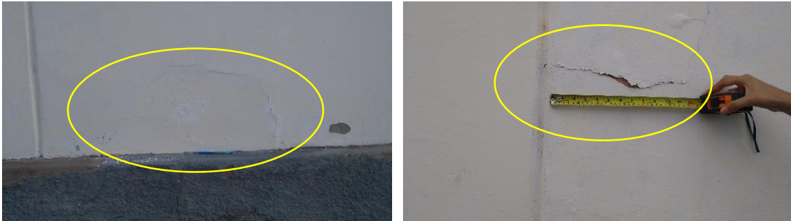
Figura 34 - Fissuras isoladas
