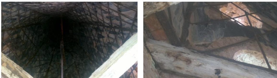
Figura 46 - Estrutura que sustenta a cobertura
