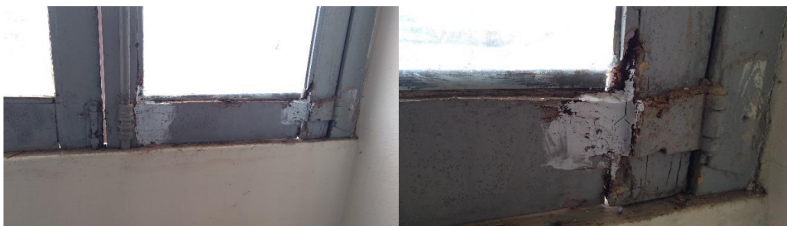
Figura 53 - Reparos feitos na esquadria
