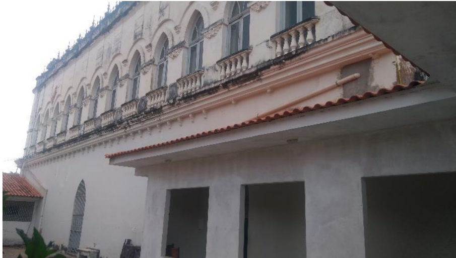
Figura 39 - Fachada lateral direita
