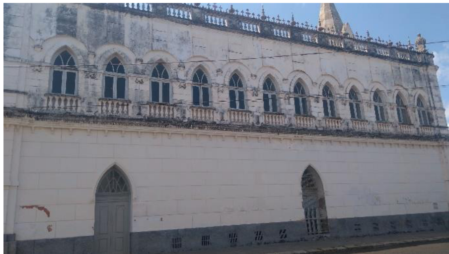
Figura 29 - Fachada Lateral Esquerda
