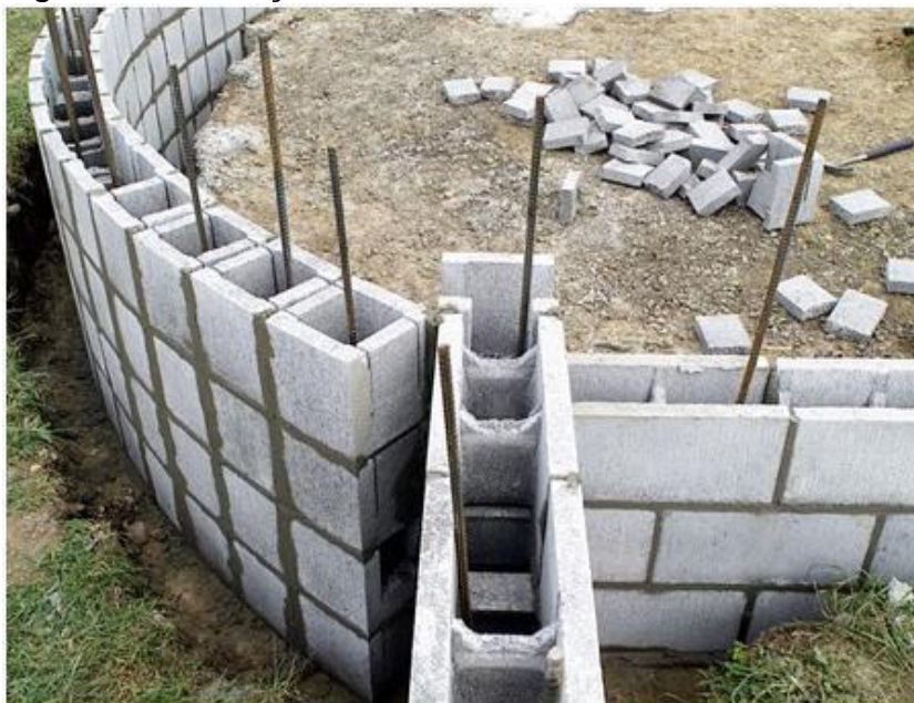
Figura 4 – Construção em alvenaria estrutural
