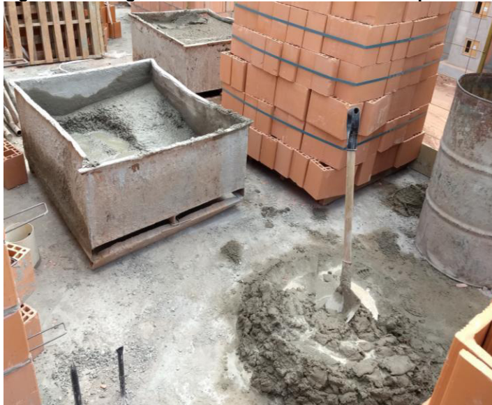
Figura 22 – Argamassa em contato com o solo prestes a ser utilizada
