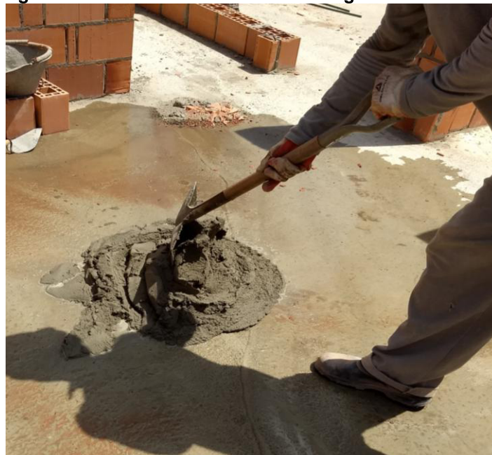
Figura 23 – Trabalhador utilizando a argamassa em contato com o solo
