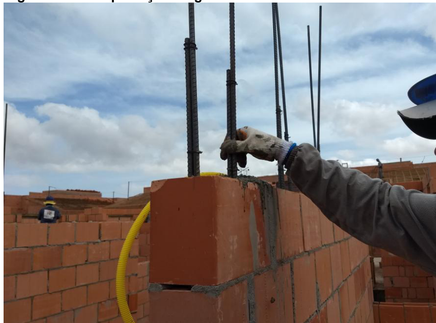
Figura 25 – Compactação do graute realizada com a armadura
