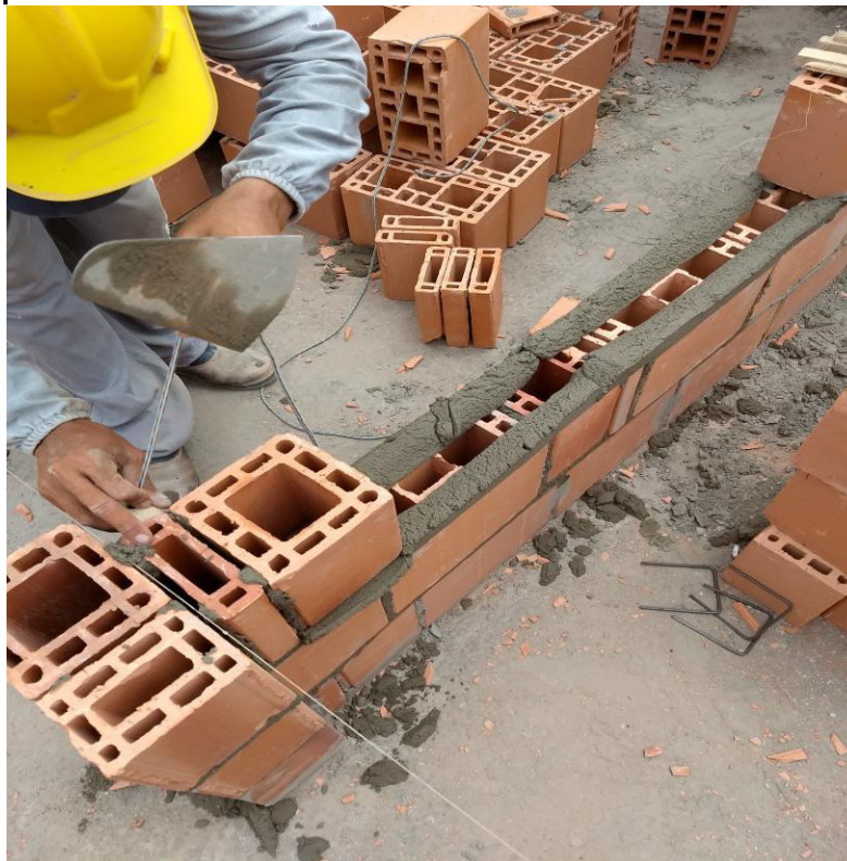
Figura 21 – Blocos sendo assentados sem os septos transversais preenchidos
