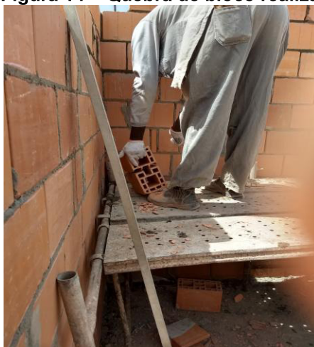
Figura 14 – Quebra de bloco realizada pelo pedreiro
