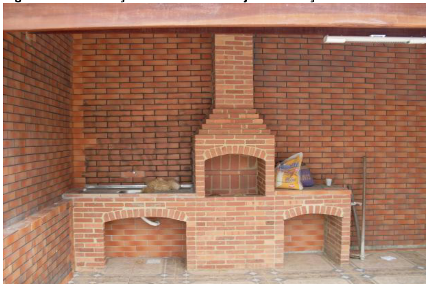
Figura 2 – Construção realizada com tijolos maciços
