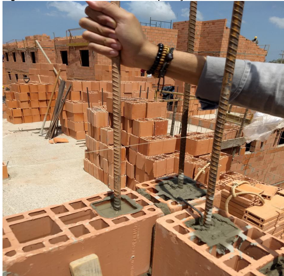
Figura 26 – Trabalhador fazendo a compactação “manualmente”
