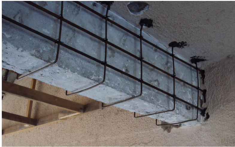
Figura 2- Armadura de complementação.
