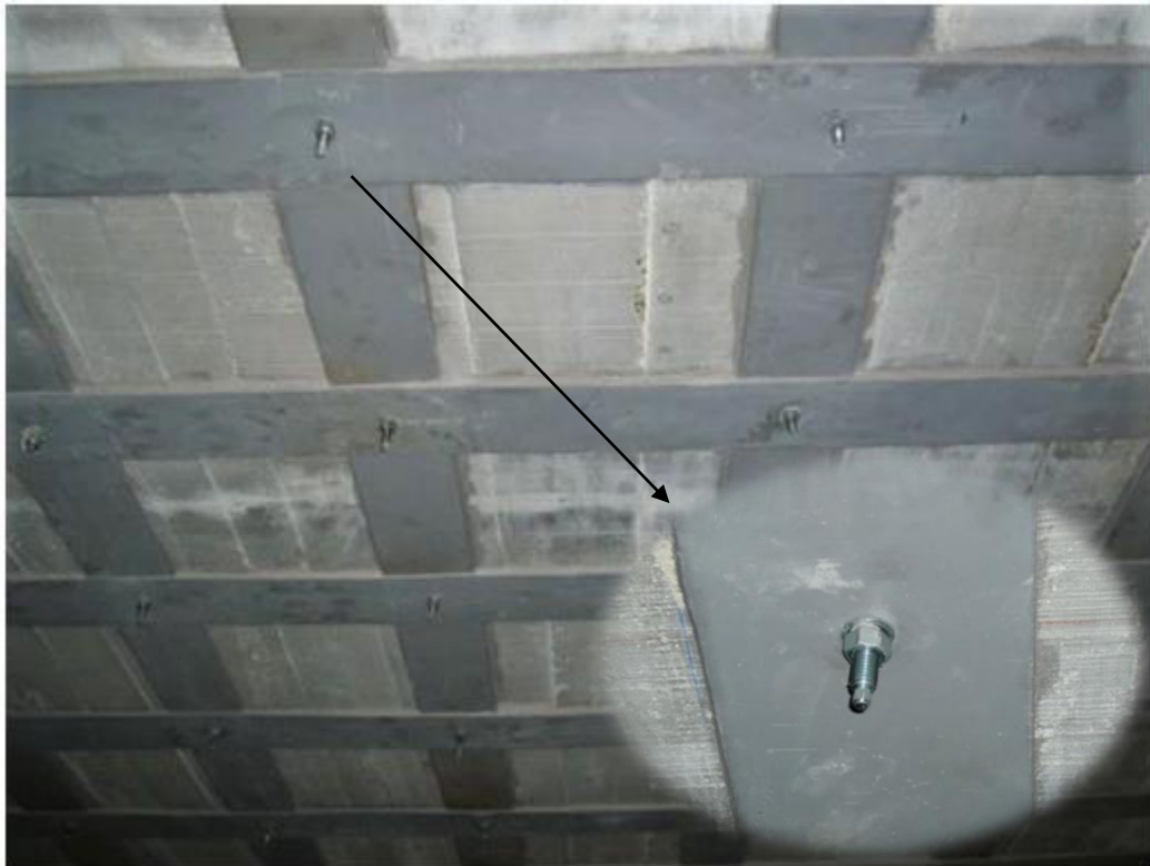
Figura 5 – Reforço de laje com chapas metálicas com adesivo e parabol.
