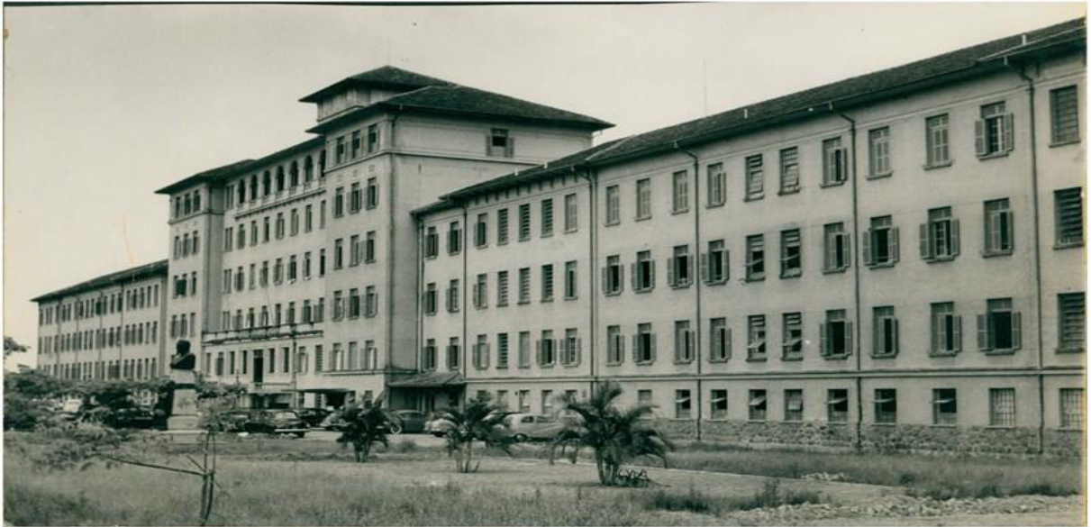
Figura 03 – Fachada principal do Hospital na época.
