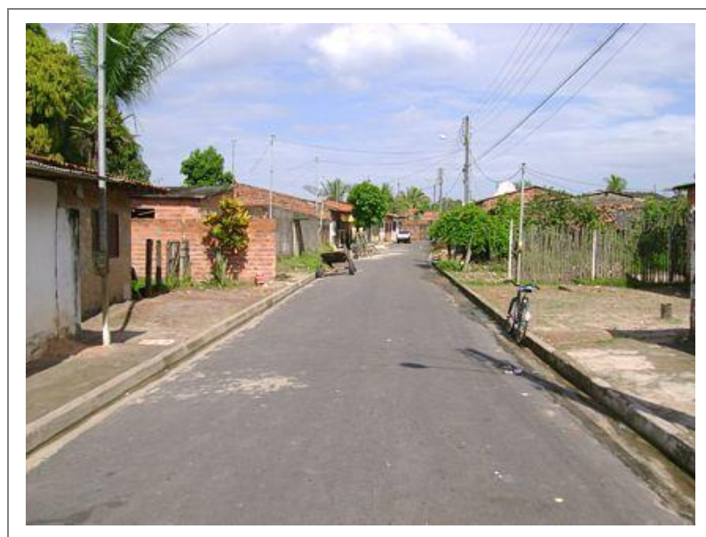
Foto 2 – Infra-estrutura satisfatória na comunidade. Fonte: Registro primário de campo, 2008.
