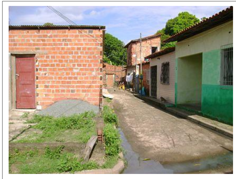
Foto 5 – Pontos com deficiências de saneamento. Fonte: Registro primário de campo, 2008.
