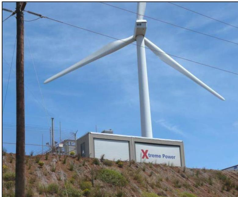
**Figura 3.4:** Sistema de armazenamento de energia com baterias de chumbo-ácido com capacidade nominal de 1.5 MW/1.0 MW integrado a um parque eólico, na cidade de Maui, Havaí (EUA). Fonte [20].
