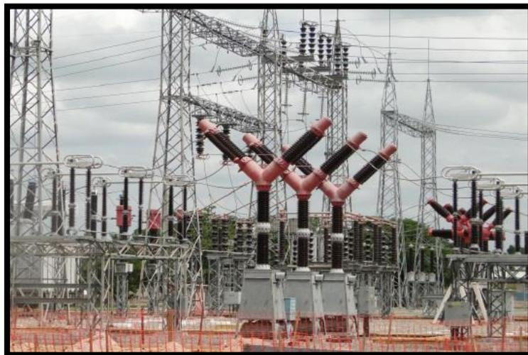
Figura 2.3 - Disjuntor interruptor de SF<sub>6</sub> em subestação de alta tensão [11]
