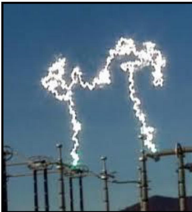
Figura 3.5 - Arco elétrico em chaves seccionadoras [38]
